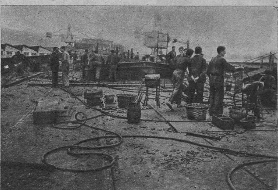
Los martillos de aire comprimido trabajan en el remachado de la cubierta superior
