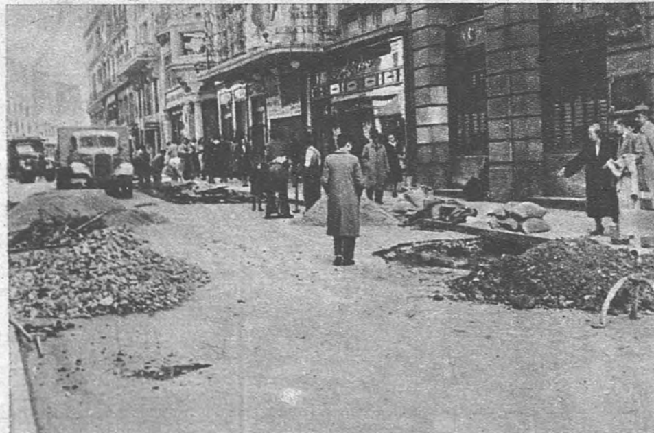
HUNDIMIENTO EN LA CARRERA DE SAN JERONIMO. —El pavimento antiguo de Madrid no sirve para el tráfico de los autobuses. El hundimiento de la Carrera de San Jerónimo es un ejemplo más de la necesidad de adecuar el suelo de la ciudad al nuevo transporte.—(Foto Pastor.)
