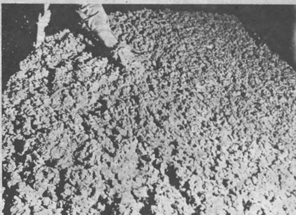
7. YA SE TIENE LA PULPA. —De esto, que parece una enorme esponja, pero que no es en realidad sino la madera desfibrada, es decir, convertida en pulpa, saldrá, después de pasar por diversas máquinas, el papel para periódicos. Es un proceso que requiere mucho tiempo
