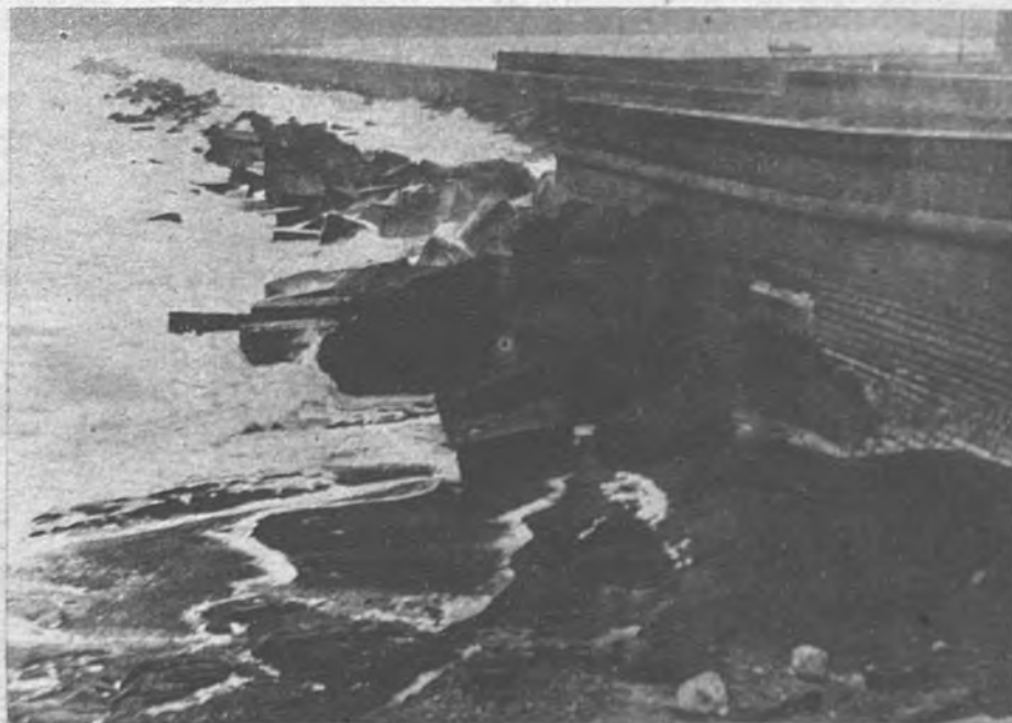
AVANZADA. —La escollera formada por los bloques, a 60 metros del rompeolas, es la primera avanzada en la defensa del puerto
