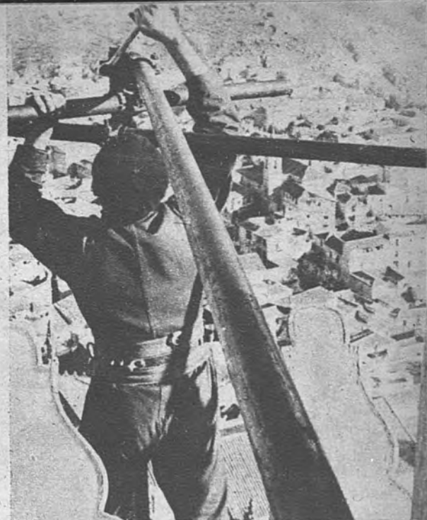
Ajustando una abrazadera sobre los tubos del andamio metálico que se eleva en la torre de la catedral
