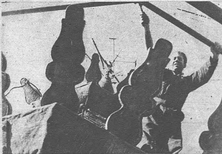
Dos aspectos gráficos de los arriesgados trabajos que exige la instalación de un andamio sobre la torre de la catedral de Toledo, necesario para desmontar la veleta, que amenaza desplomarse
