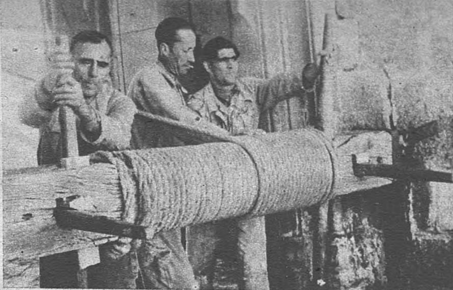
Torno primitivo, que aun se utiliza en la catedral de Toledo para subir los materiales hasta la torre
