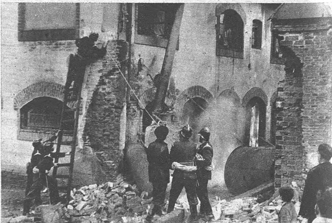
EXPLOSION EN TETUAN. — En una fábrica de caramelos de Tetuán de las Victorias hizo explosión una de las calderas. Una de las naves de la fábrica quedó destruida y resultaron heridos varios operarios. Los bomberos intervinieron rápidamente
