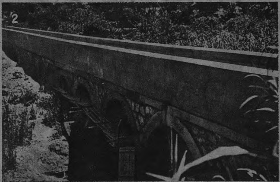
NUEVOS RIEGOS.—Canales de reciente construcción en las márgenes del río Guadalorce
