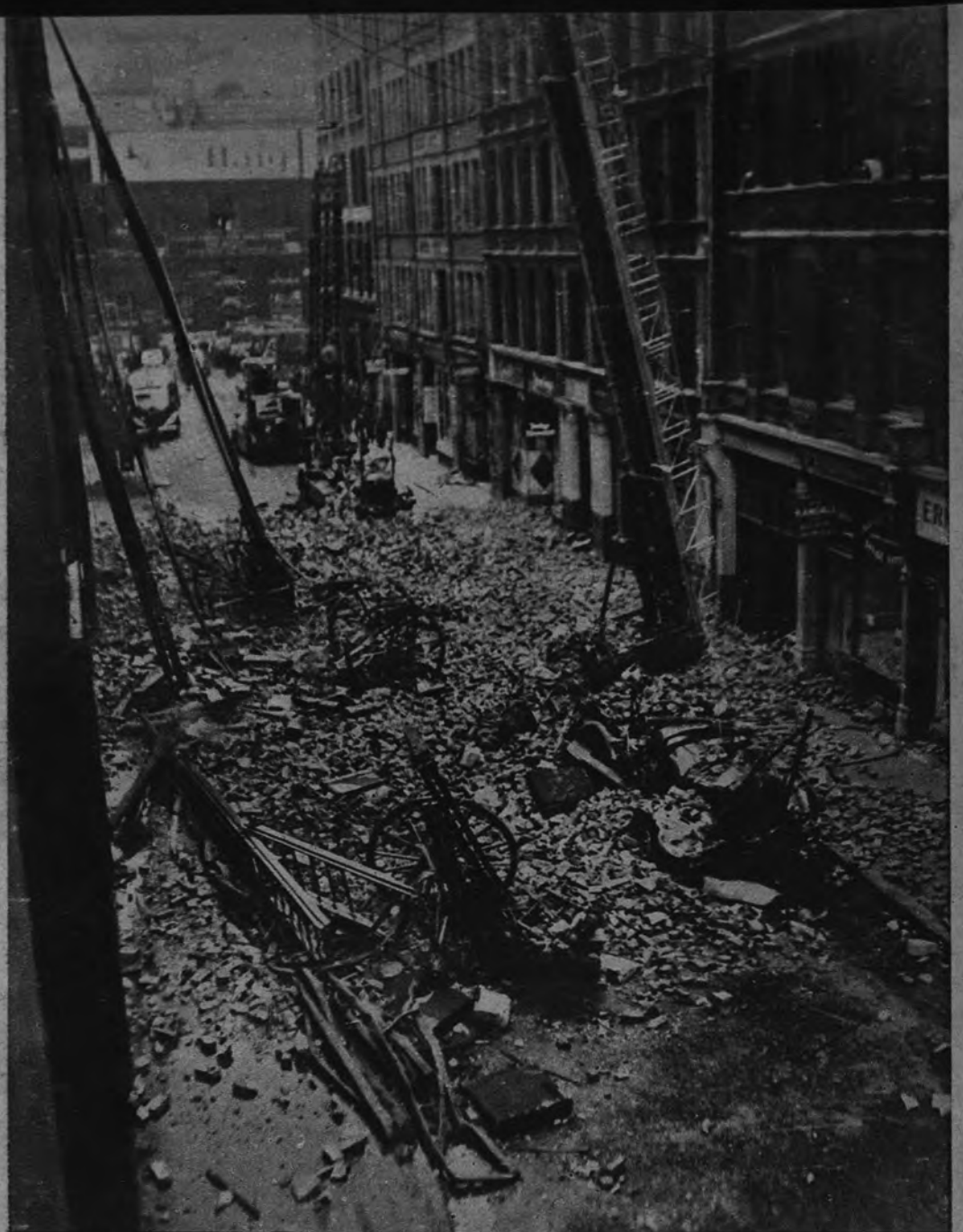
INCENDIO EN LONDRES Un incendio, originado en unos almacenes londinenses, ocasiona la muerte de seis bomberos al derrumbarse una de las paredes del edificio. Otros dieciséis más fueron hospitalizados con heridas de poca importancia. Este ha sido el más grave incendio registrado en Londres desde el final de la guerra. (Foto Ortiz-I. N. P.)
