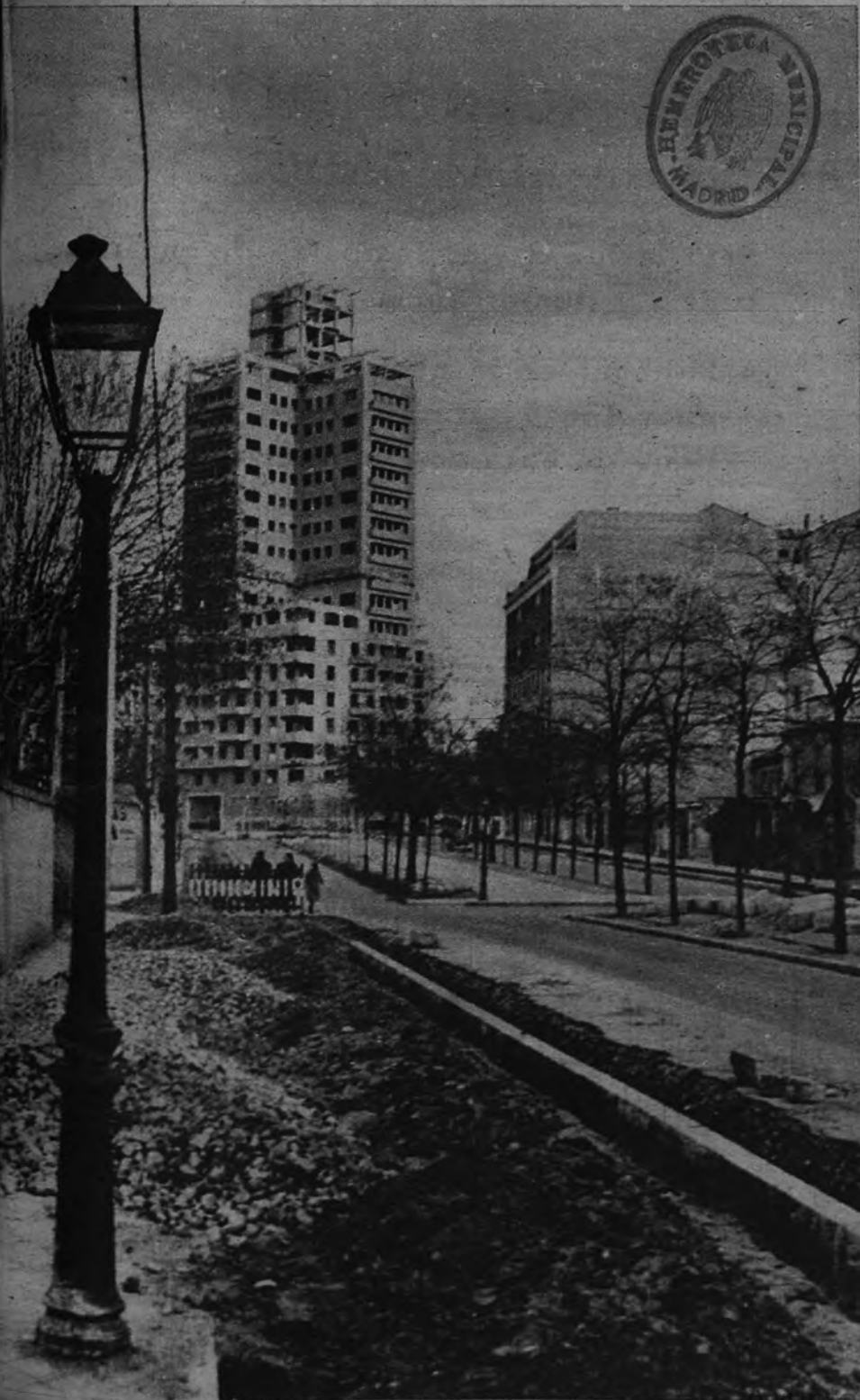
SUPRESION DE UN BULEVAR En la calle de María de Molina, continuación de la autopista de Barajas (Madrid), se están realizando obras para dejar la necesaria holgura al tráfico ensanchando las aceras laterales y suprimiendo el andén central. Al fondo, el elevado edificio que domina aquel núcleo de urbanización.—(Foto Cortina.)
