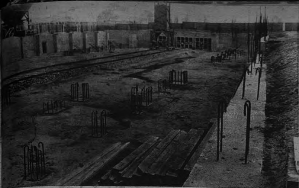
Estado actual de las obras: terminados la cimentación, drenaje y cerramiento de criptas
