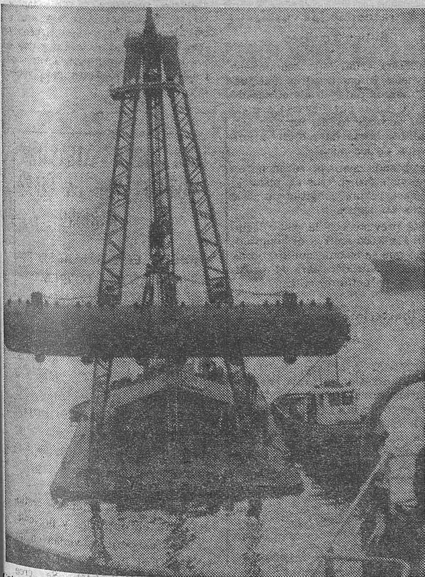
Calderín para central térmica de Soto de Ribera, grupo segundo. Peso de 107 toneladas. Procedente de Nueva York transportada por el v. «EX-PEDITOR», de American Export Isbrandtsen Lines
