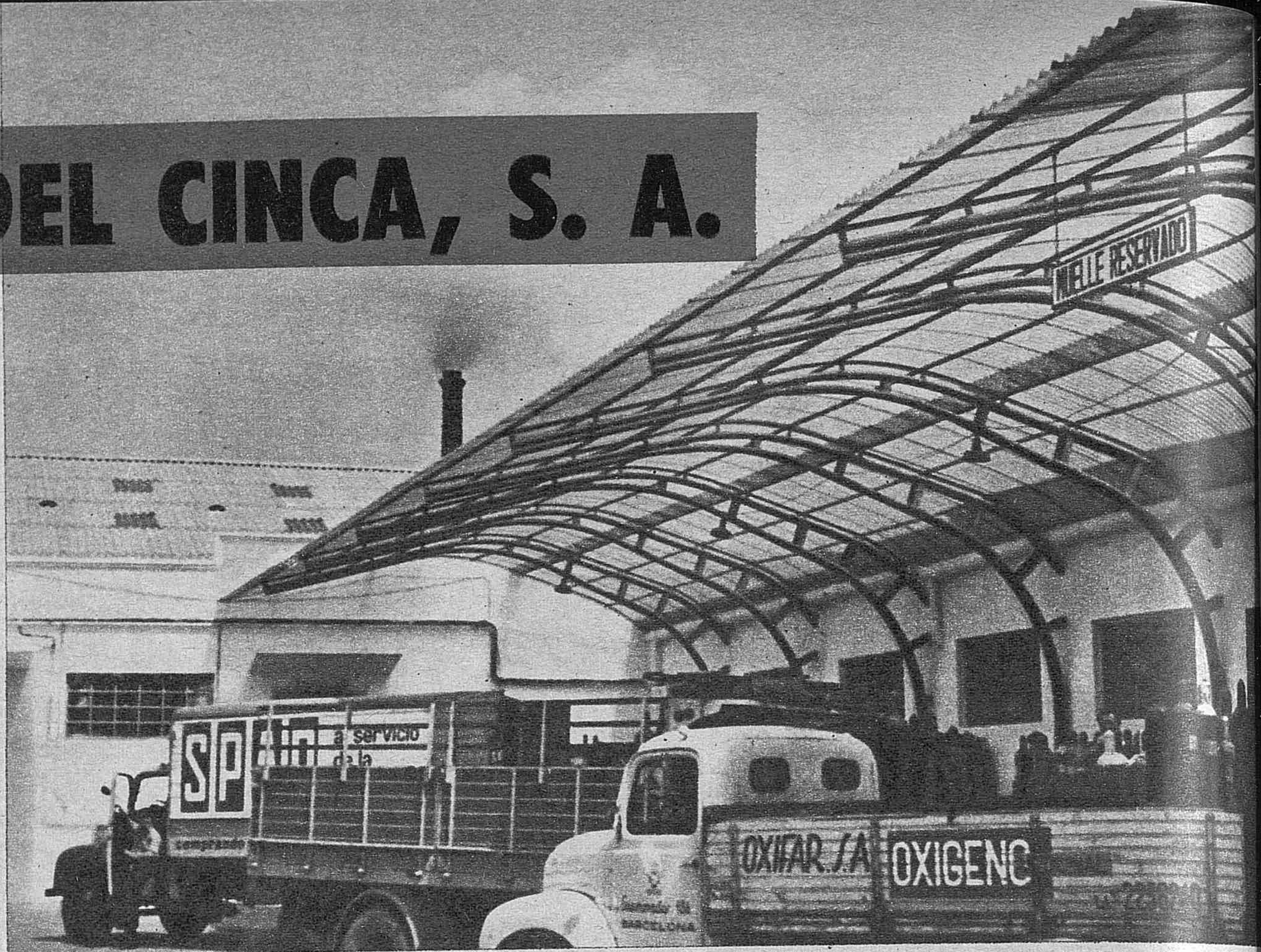
Marquesina curva de 32 m. de longitud y 9 m. de voladizo realizada con placa CINCAPLAST
