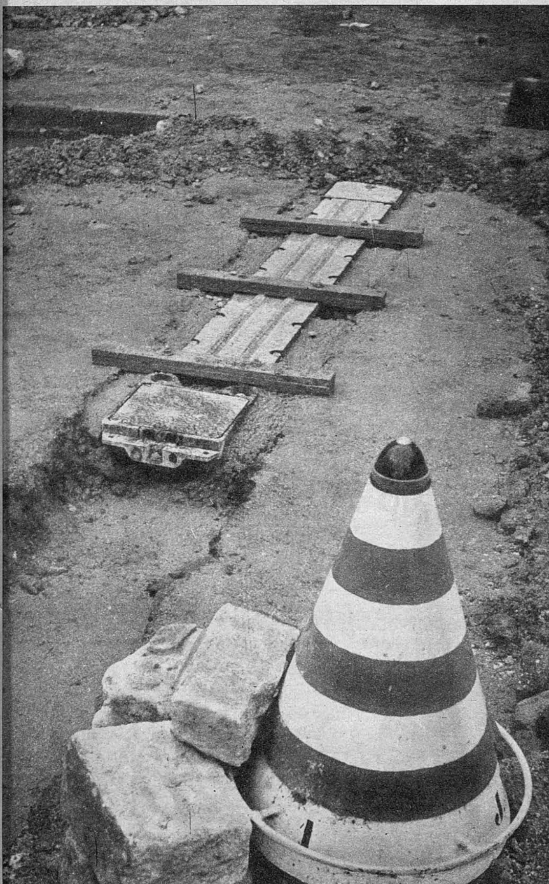
SEÑALES AUTOMÁTICAS. —El tráfico madrileño registra algunas novedades en su ordenación. Esta es una de las bandas que, mediante procedimiento automático, señalará la densidad de circulación. Ha sido colocada en el cruce de la calle de Lista con la de Conde de Peñalver y se encuentra en período de pruebas.
