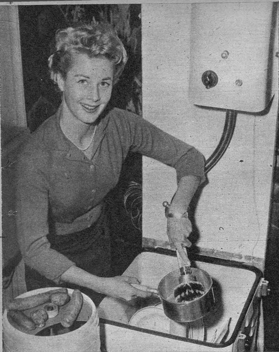
ROBOT DOMESTICO. —Compuesto de un motor y un cubo, este aparato sirve para lavar la ropa y la vajilla, limpiar cacerolas, moler café, cortar y mezclar legumbres, dar lustre a los zapatos, dar cera y masaje. Y es aspiradora y lavacoches
