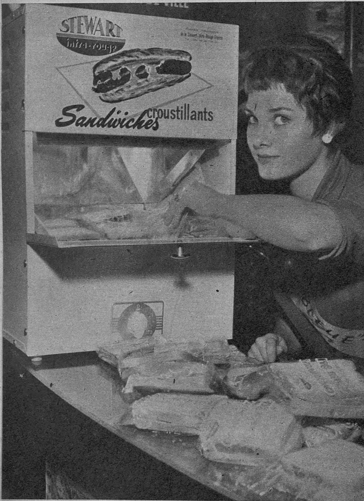
"SANDWICHES". —Un pequeño aparato con una potencia de mil vatios y dotado de lámparas de rayos infrarrojos permite poner a punto de apetito a estos "sandwiches" sin quitarles su envoltura de celofán. El invento ha sido presentado en París por esta bella
