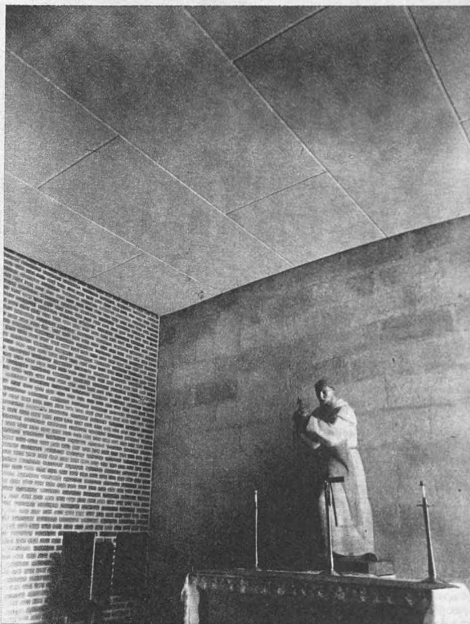
Una de las capillas en la Residencia de los RR. PP. Dominicos de las Arcas Reales de Valladolid. Techos de tablero «Tablex» perforado. Arquitecto, don Miguel Fisac. Premio Internacional de Viena
