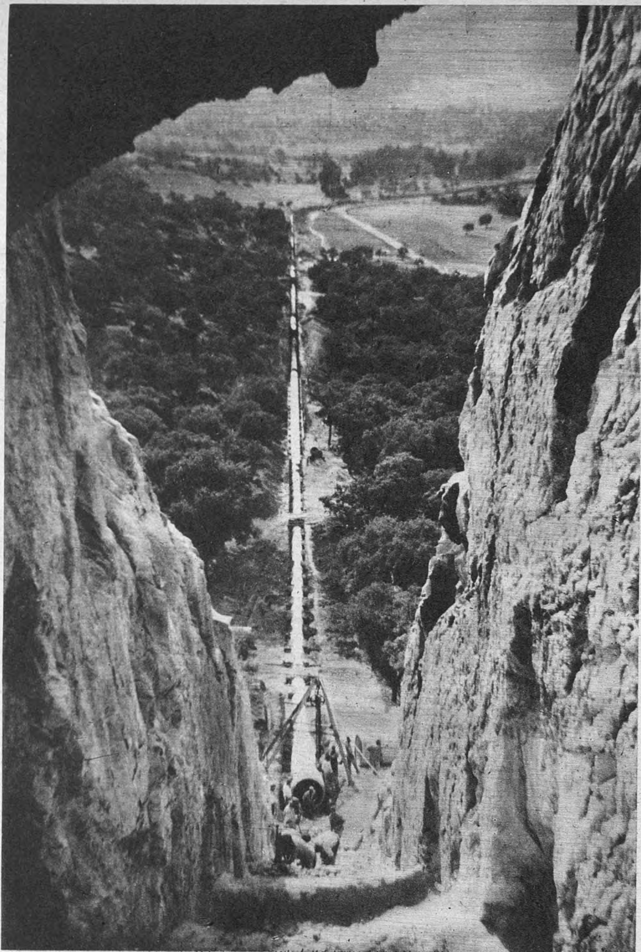
Puente sifón Garcisobacos, en la conducción de aguas a la zona gaditana
