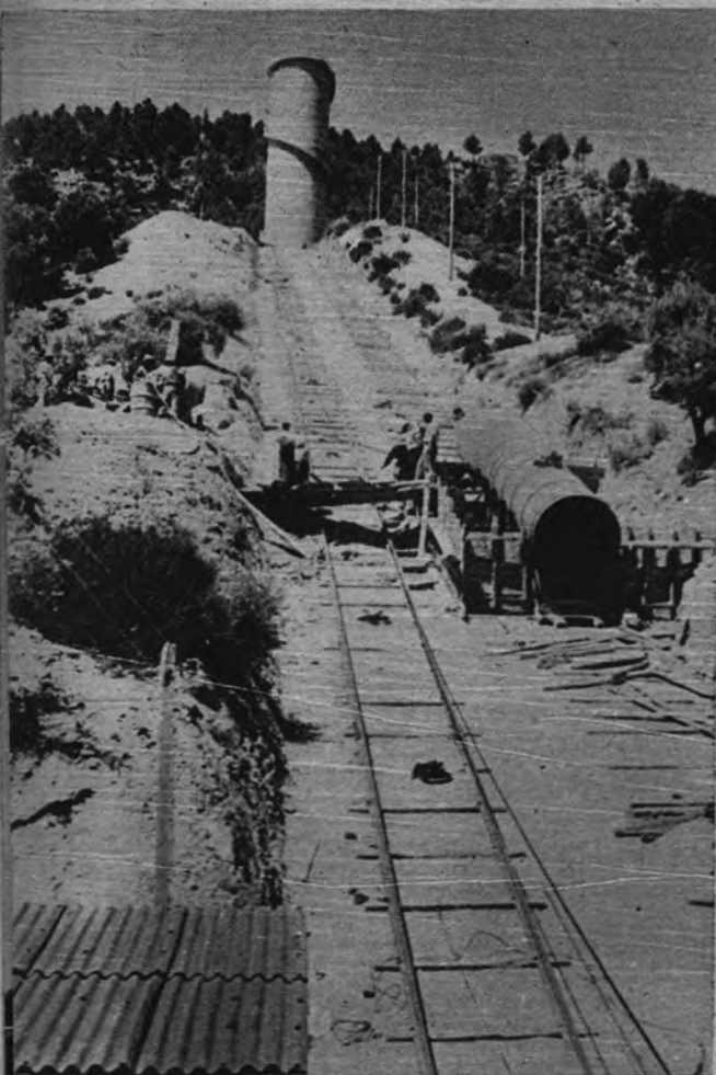
NUEVA CENTRAL ELECTRICA. —En la sierra del Segura se está construyendo una central eléctrica. La fotografía muestra el plano inclinado de la tubería reforzada del salto Miller. Al fondo, la chimenea de equilibrio, de cuarenta y cinco metros, por donde salen las aguas del río Segura.—(Foto Cifra.)
