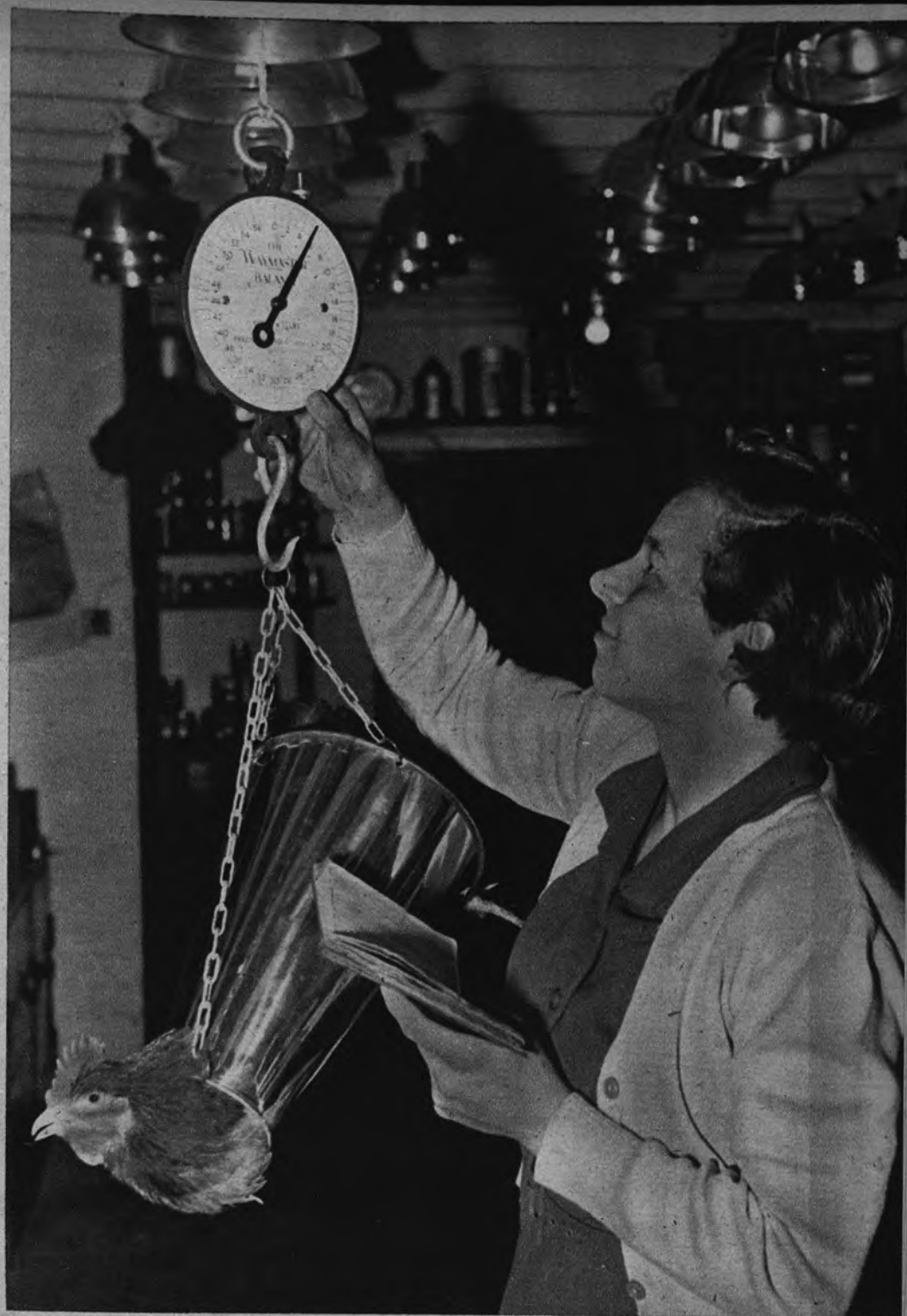
PARA PESAR POLLOS. —Pesar un pollo en vivo es cosa difícil. Esta tendera inglesa ha inventado el sencillo aparato que ven, que consiste en un sencillo tubo de hoja de lata, que facilita extraordinariamente la operación de la pesada
