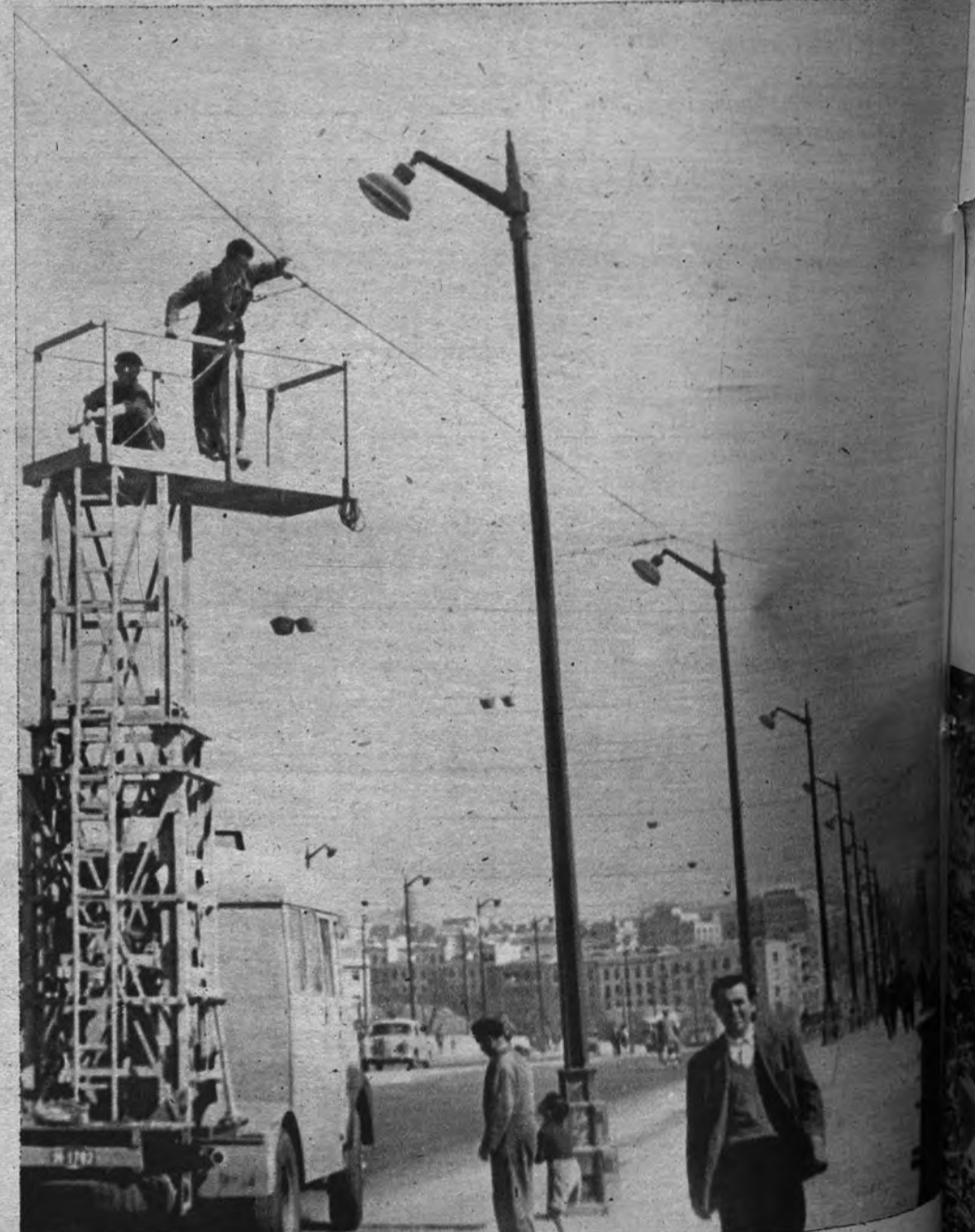
TROLEBUSES SOBRE EL MANZANARES. —El tendido de la red eléctrica que enlazará Puerta Bonita con el centro de la ciudad, se lleva a un ritmo acelerado. Aquí vemos los trabajos sobre el Puente de los Héroes del Alcázar.—(Foto M. Zurdo.)
