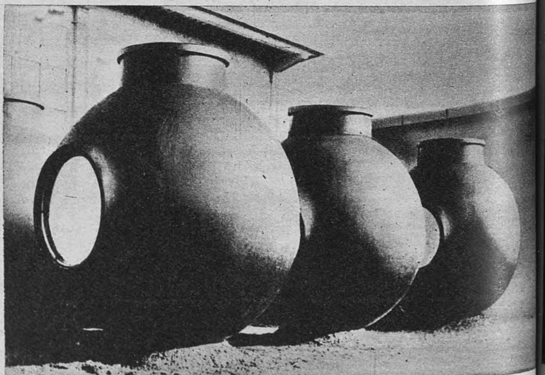
REFUGIO ANTIATÓMICO.—Con aire de bodegón, estos son los modelos de cemento que una empresa suiza ha construido, destinados a la protección de la población civil y de las fuerzas armadas en caso de ataques atómicos.—(Foto Cifra.)
