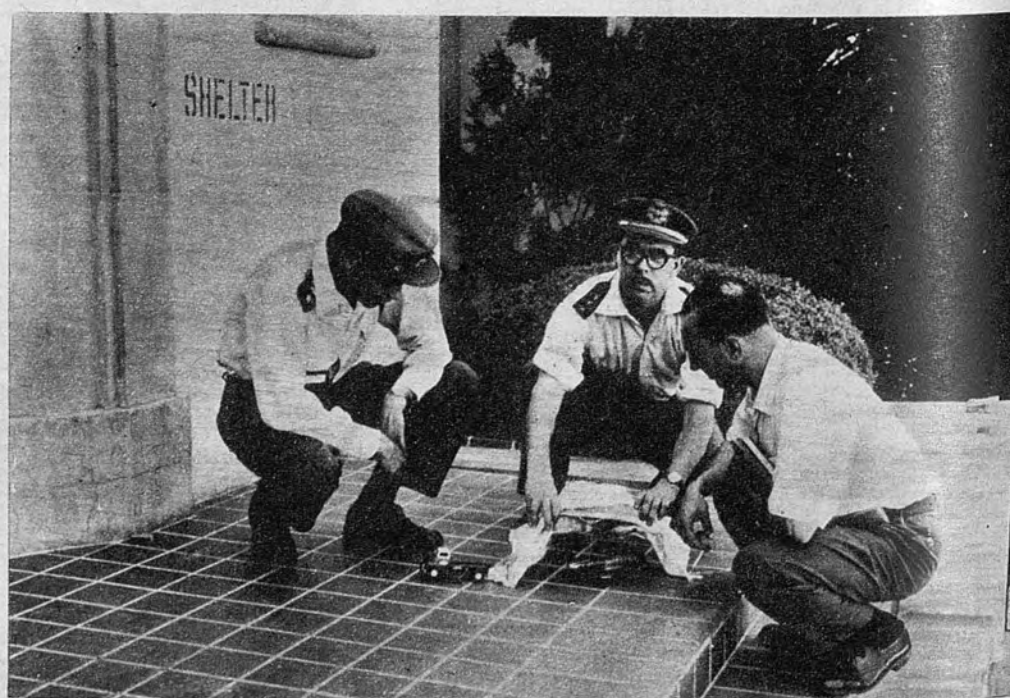
INVENTO ESPAÑOL. —Los capitanes españoles Ugedo, Marayo y Herrero prueban su sistema de extinción de incendios para aviones siniestrados en tierra con unos modelos en miniatura. Se basa en una cubierta de material flexible. (Cifra.)
