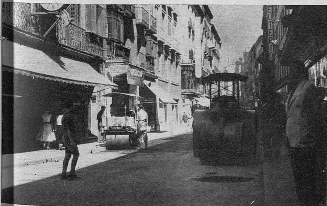
ASFALTO EN LA CALLE DE FUENCARRAL. —Las obras que se han realizado en la calle de Fuencarral para levantar los raíles del tranvía están a punto de terminar. En la foto, las apisonadoras pasan sobre el cemento vertido. —(Foto Pastor.)
