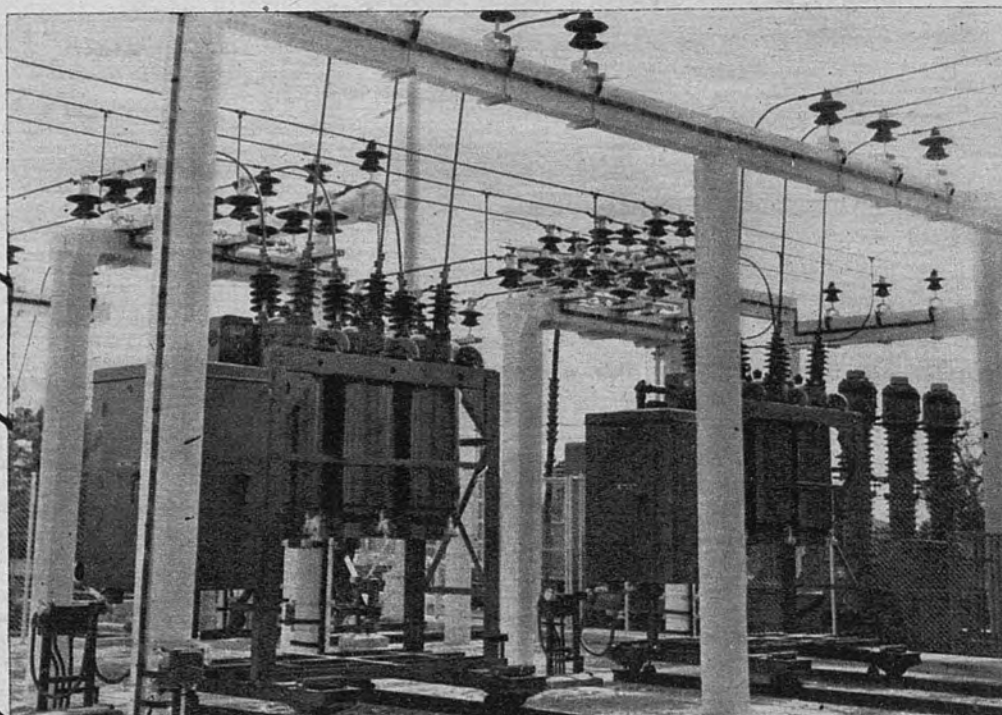
Interruptores FK-438 34,5 kV-1.000 MVA. Subestación de Reus RENFE.
