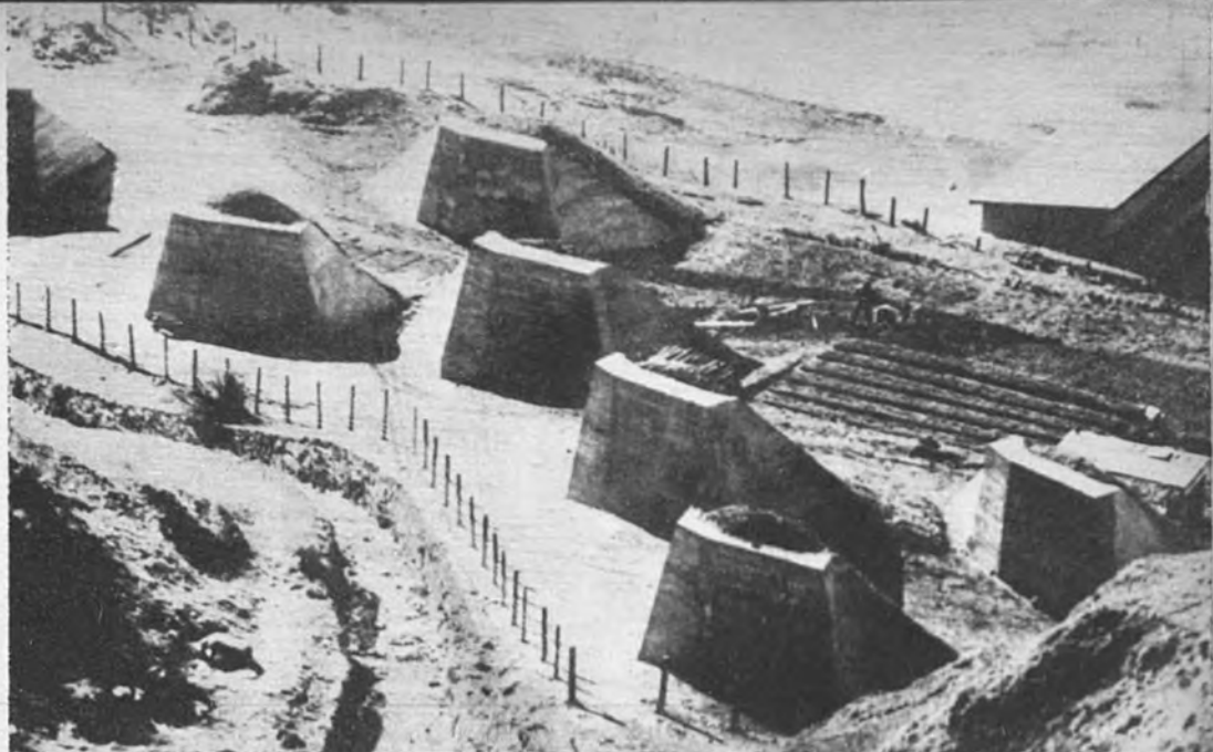
DEFENSA PARA LA NIEVE. —Frente a las montañas de Andermatt, en Suiza, se levantan estos bloques de cemento armado, que harán frente a los aludes de nieve, y constituirán defensa contra la muerte blanca y destrozos de los pueblos
