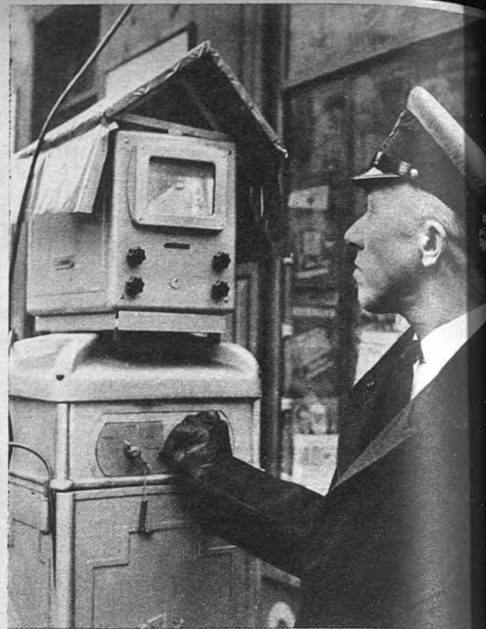
VIGILANDO LA CIRCULACION. —Este aparato de televisión permite al agente tener a la vista el desarrollo de la circulación e impedir accidentes. Ha sido instalado en la ciudad de Bruselas. — (Foto Fiel.)
