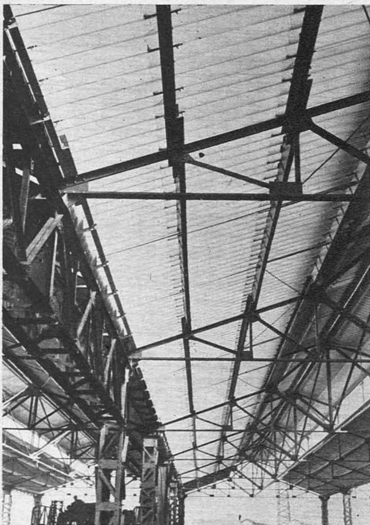
La luz penetra en el interior de la nave a través de las placas de "VERONDULIT" colocadas en la cubierta.
