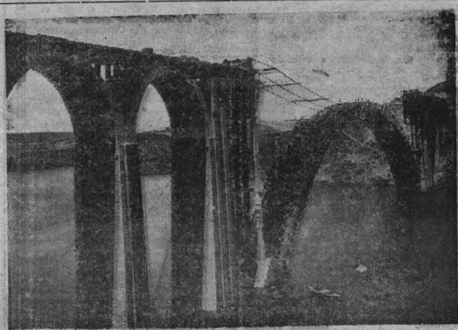
Viaducto sobre el Esla. El mayor arco de hormigón armado de Europa
