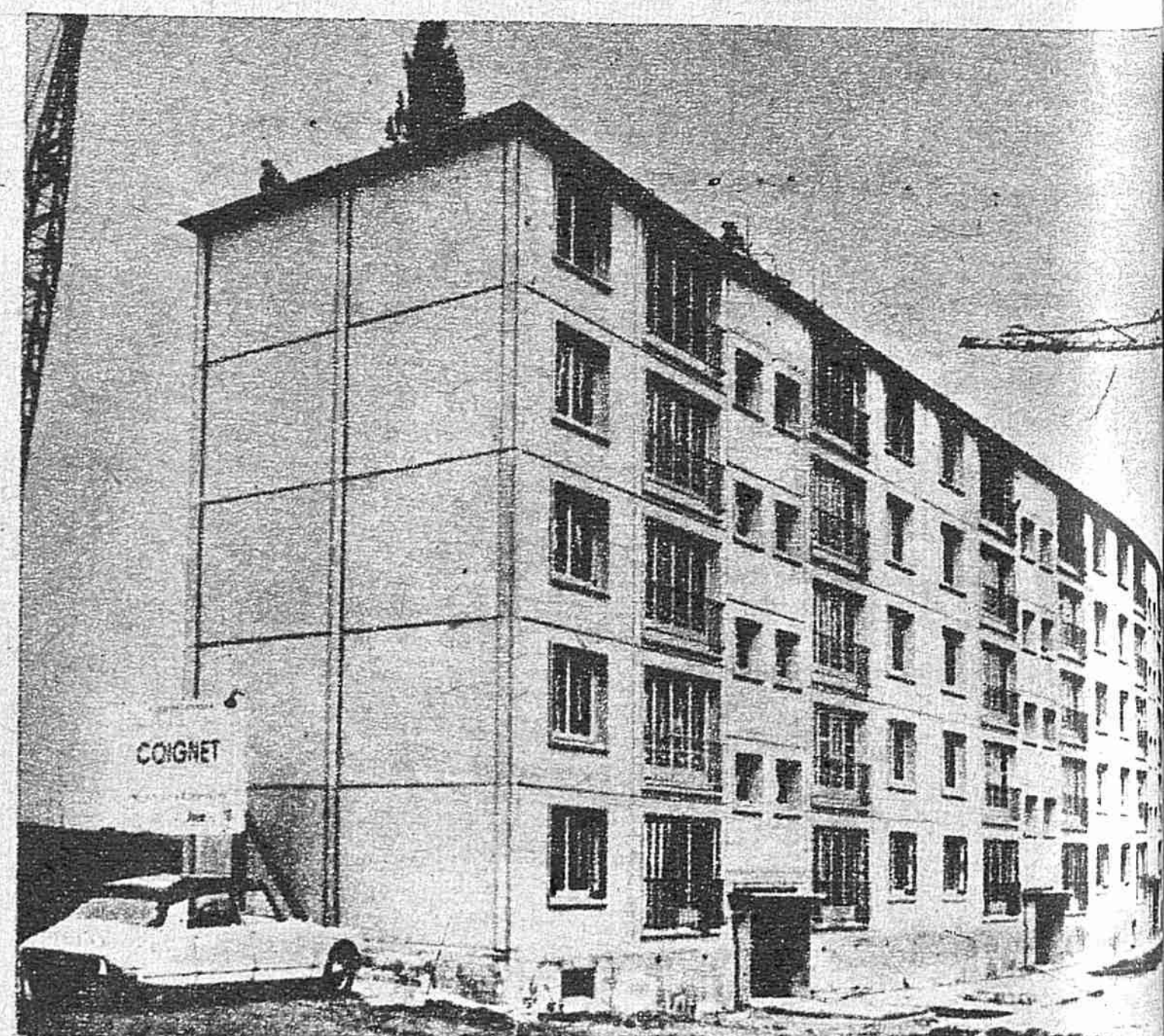
UNA MARCA EN LA CONSTRUCCION: «OPERACION CENTELLA». —En Asnieres (Francia) veinte obreros han terminado en nueve días la construcción de un inmueble de cuatro pisos capaz para albergar a doscientas personas, gracias a la utilización de elementos prefabricados. Ofrecemos aquí, a la izquierda, el trabajo al cabo de las seis primeras horas y una vez finalizado. Esta marca casi deportiva ha sido llamada «operación centella». (Fiel.)
