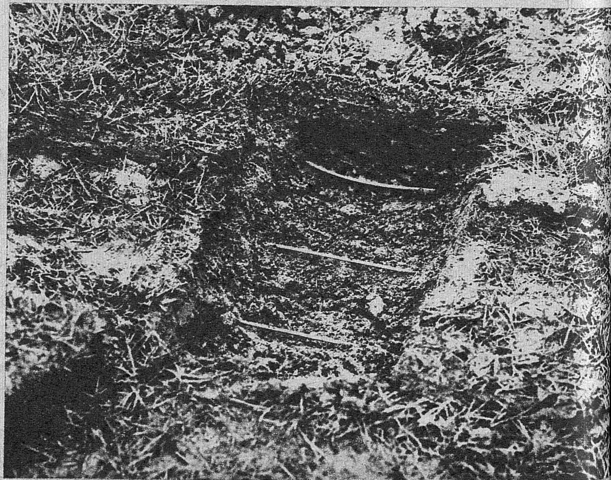
NUEVA TECNICA PARA CALENTAR EL SUELO DEL ESTADIO. —En Londres se han ensayado unas pruebas para calentar la tierra por medio de tubos con cables eléctricos. La nueva aplicación de la técnica está especialmente pensada para los deportes. Se trata de un procedimiento eficaz para derretir y eliminar la nieve o el hielo cuando hay partido. El aparato va colocando los tubos a cierta profundidad, y ahí vemos en un hoyo los cables
