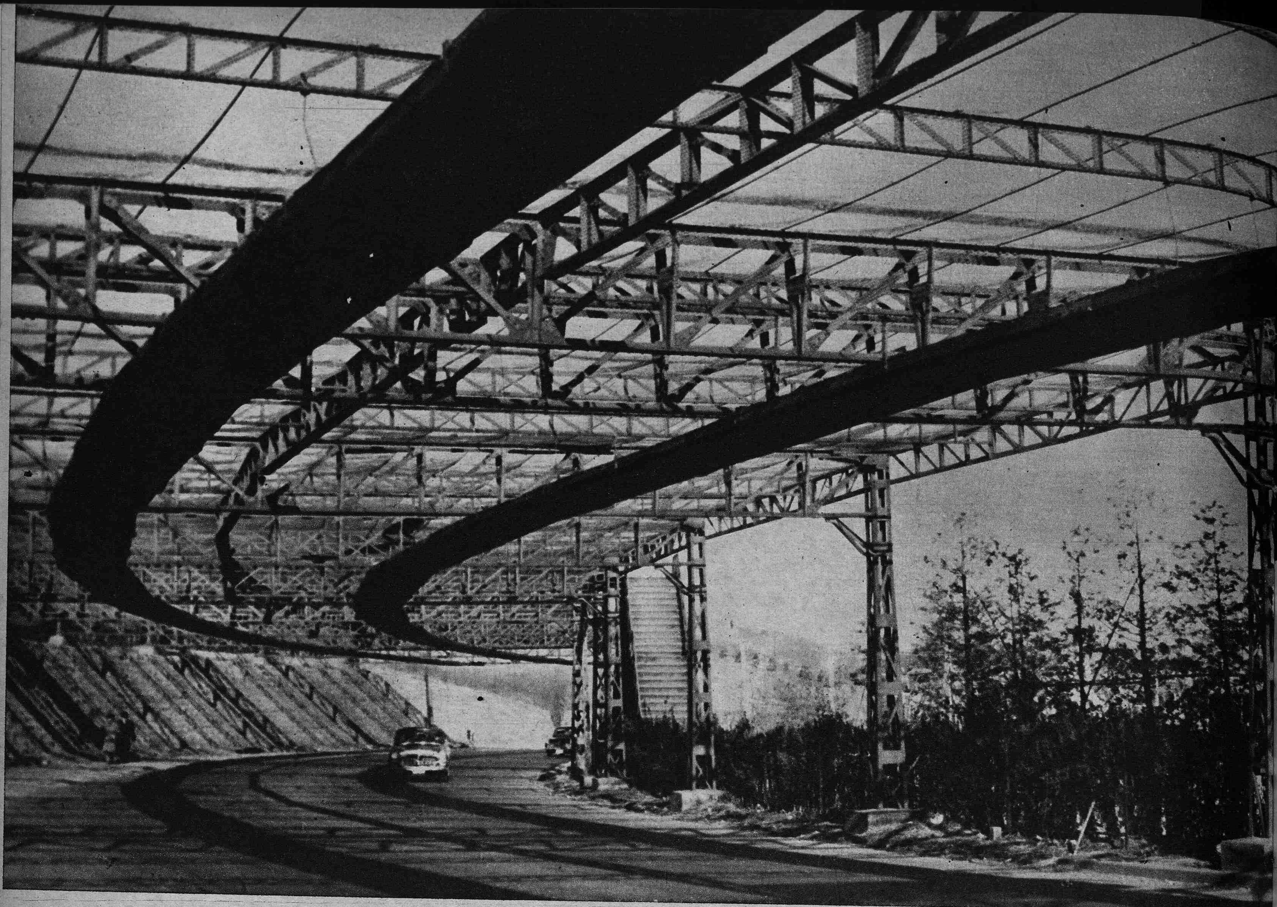
TELA METALICA PARA PROTEGER LA CARRETERA. —La carretera japonesa que va de Tokio a Yokohama cruza un importante y frecuentado terreno de golf. Continuamente las pelotas del juego caían a la carretera con peligro para los automóviles y especialmente para los motoristas. Una red de tela metálica preserva ahora el camino. Estas gigantescas construcciones metálicas sirven además de puente sobre la carretera. (Torremocha.)
