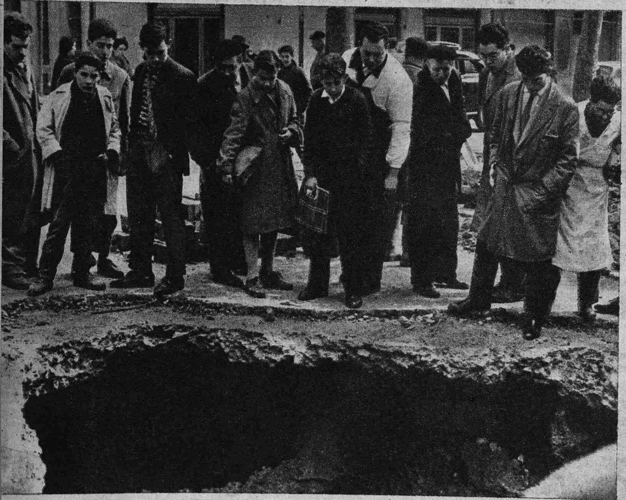
HUNDIMIENTO CALLEJERO. —En la calle del General Mola, esquina a la de Jorge Juan, en el lugar donde se efectuaban unas obras de reparación de las conducciones del subsuelo, se produjo la rotura de una cañería. Al inundar el pozo de las obras, el agua socavó el terreno, que se hundió, abriendo un gran bostezo en el pavimento. Las características del accidente permiten clasificarlo como un caso de «socavón a cielo abierto». (Europa-Press.)
