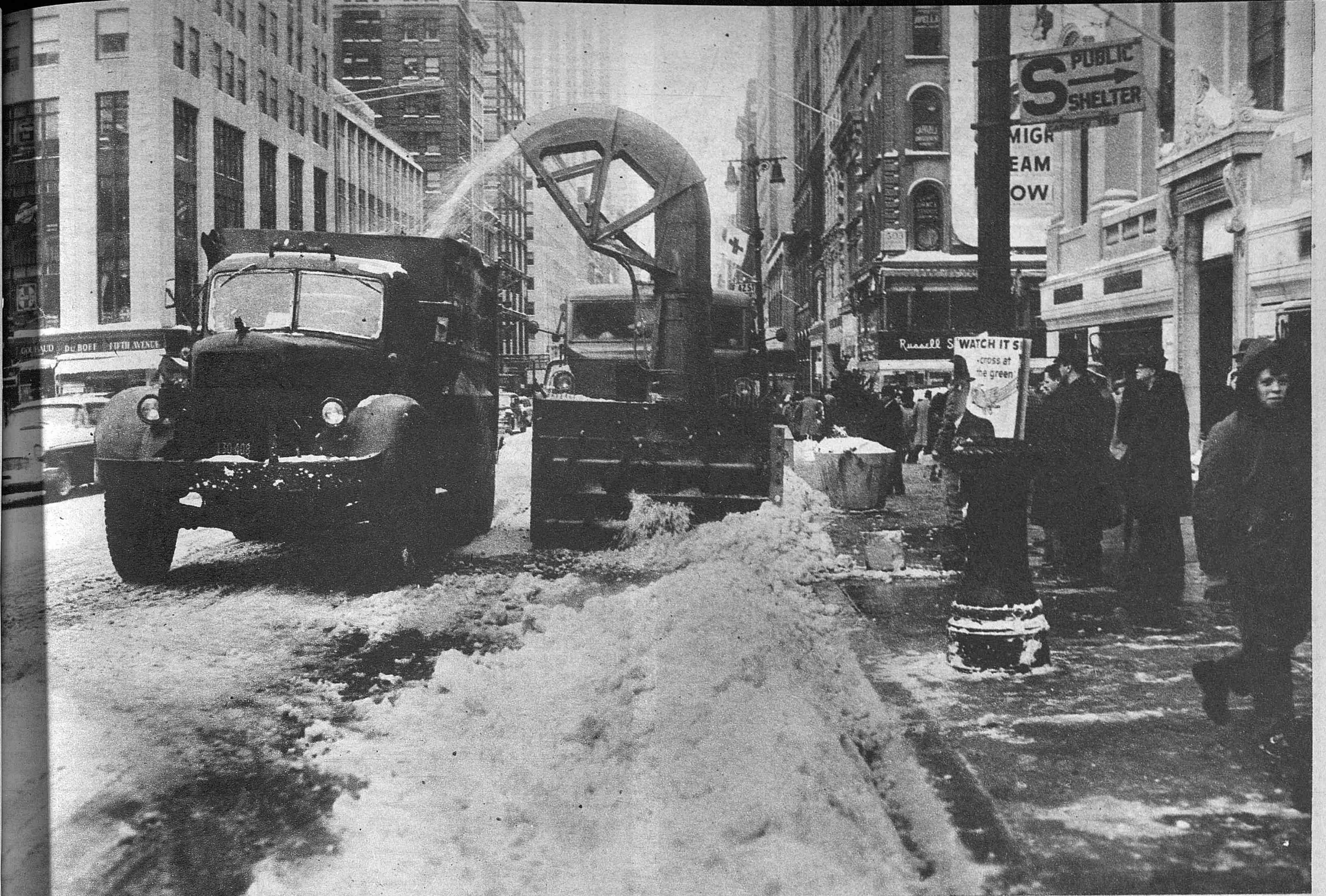
LA TECNICA DE QUITAR LA NIEVE EN NUEVA YORK. —La intensa nevada que cayó recientemente sobre Nueva York dejó prácticamente intran- sitable la ciudad. Rápidamente, con la urgencia del caso, entraron en acción las máquinas quitanieves. Aquí las vemos en plena, eficaz y limpia ac- ción. Un camión, dotado en la parte delantera de un tornillo sin fin, recoge la nieve, la eleva y el camión compañero recoge la carga.—(K.-Nemes.)
