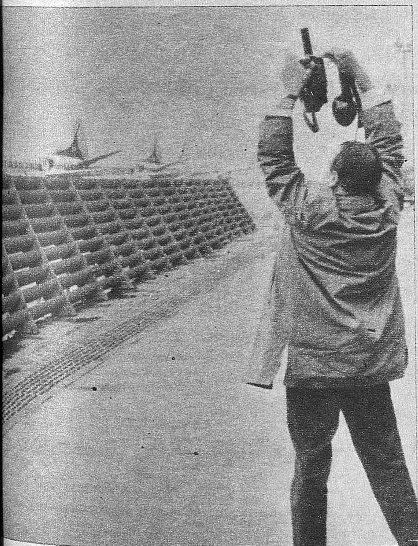
LOS REACTORES. Los reactores que aterrizan y despegan en el aeropuerto de Madrid producen mucho ruido y grandes vibraciones. Para aminorar éstas, la Compañía Air-France ha instalado en los «Boeing» este biombo o «pare-vent». — (Fotografía de Torremocha.)
