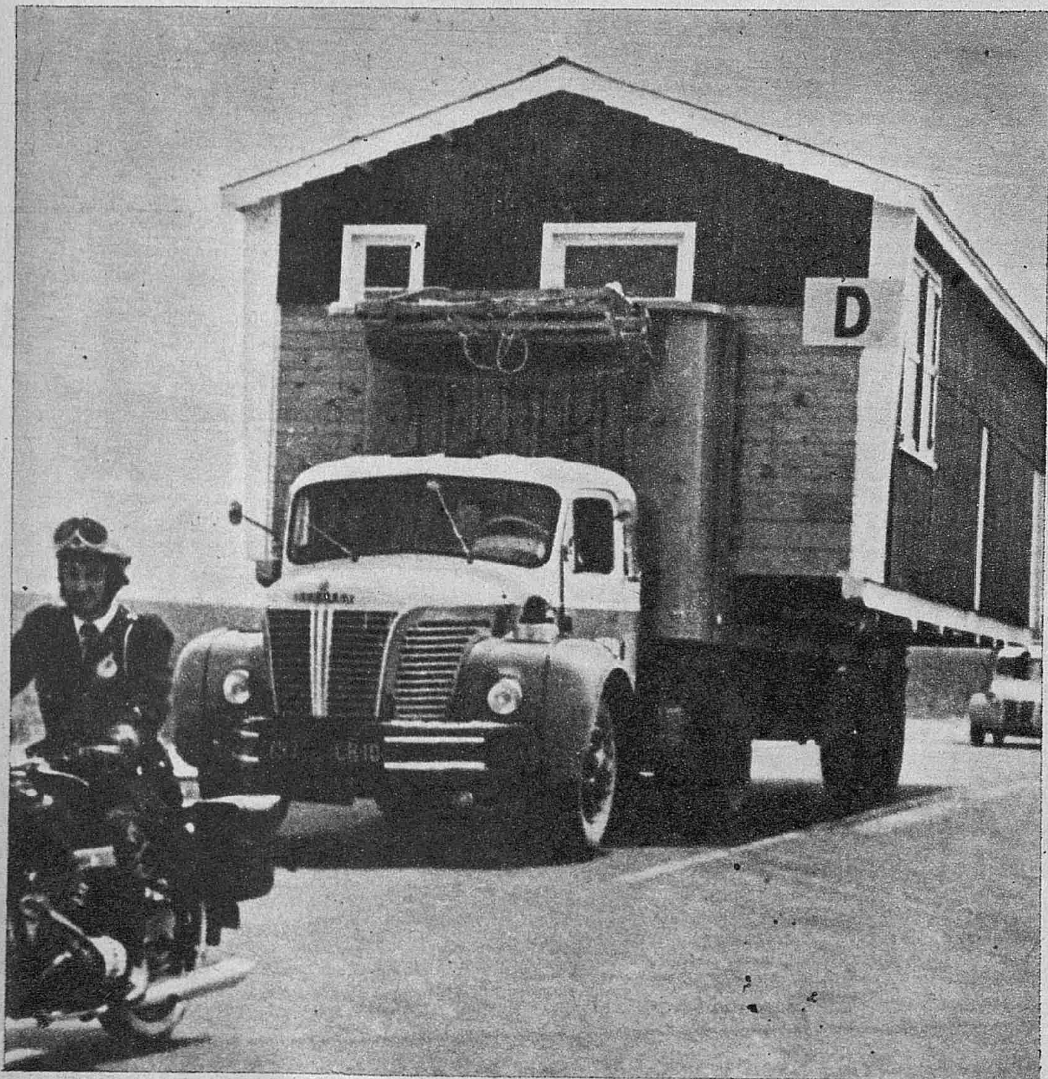
DISTRIBUCION DE CASAS A DOMICILIO. —Cada vez es más frecuente la prefabricación de casas que luego son transportadas, desde los talleres donde nacieron, hasta el sitio que ocuparán. Una empresa francesa se dedica a remitirlas a sus compradores, sirviéndolas a domicilio. Aquí vemos al vehículo repartidor, escoltado por policía de carreteras para advertir a los automovilistas y evitar cualquier peligro posible.—(Fotografía de Fiel.)
