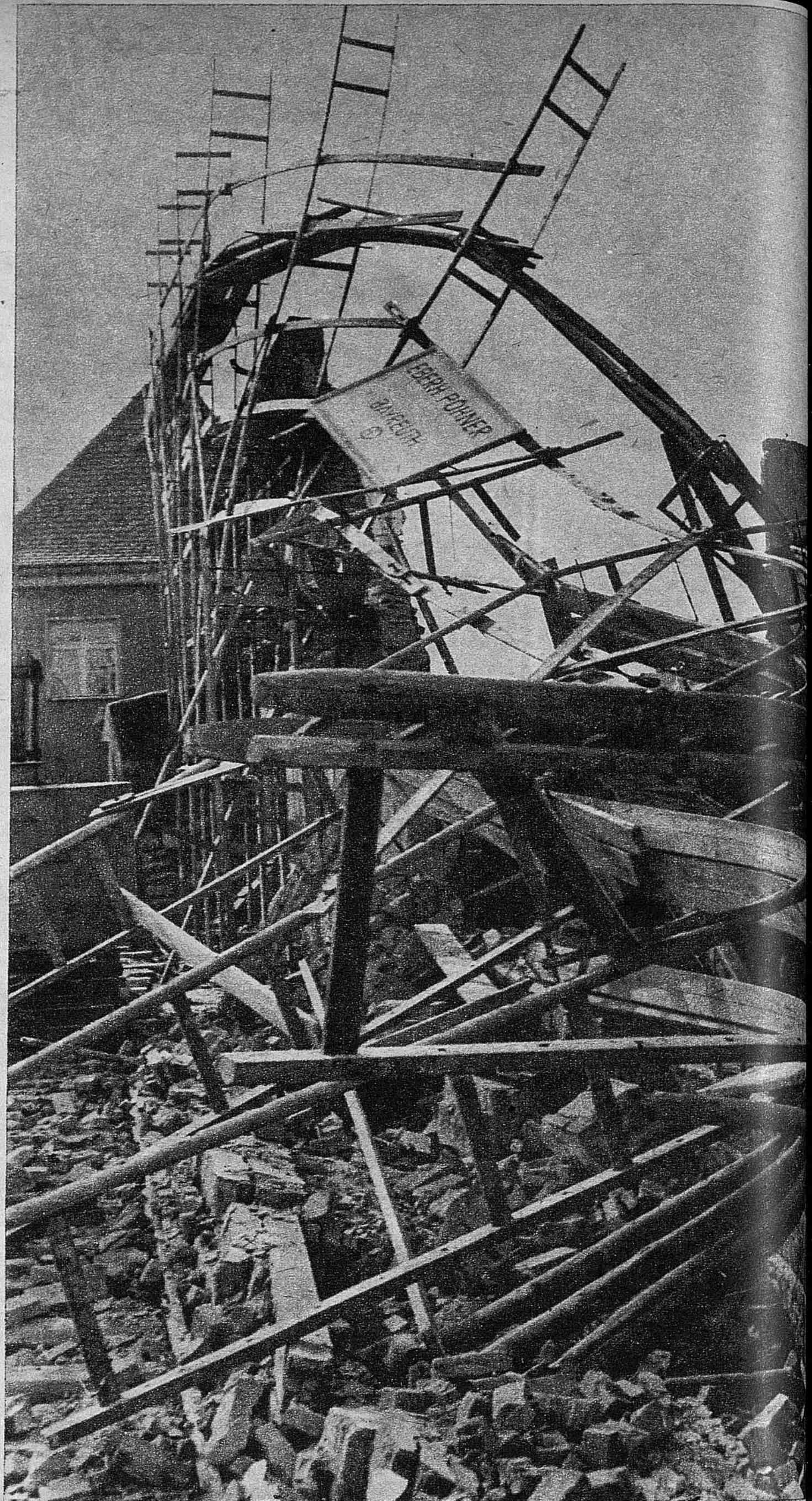
VIBRACION DESTRUCTORA. —Un avión a reacción en un vuelo rasante dejó reducido a un hacinamiento informe de hierros y de astillas un moderno edificio que se construía en Beirut. La vibración sola creó estas ruinas
