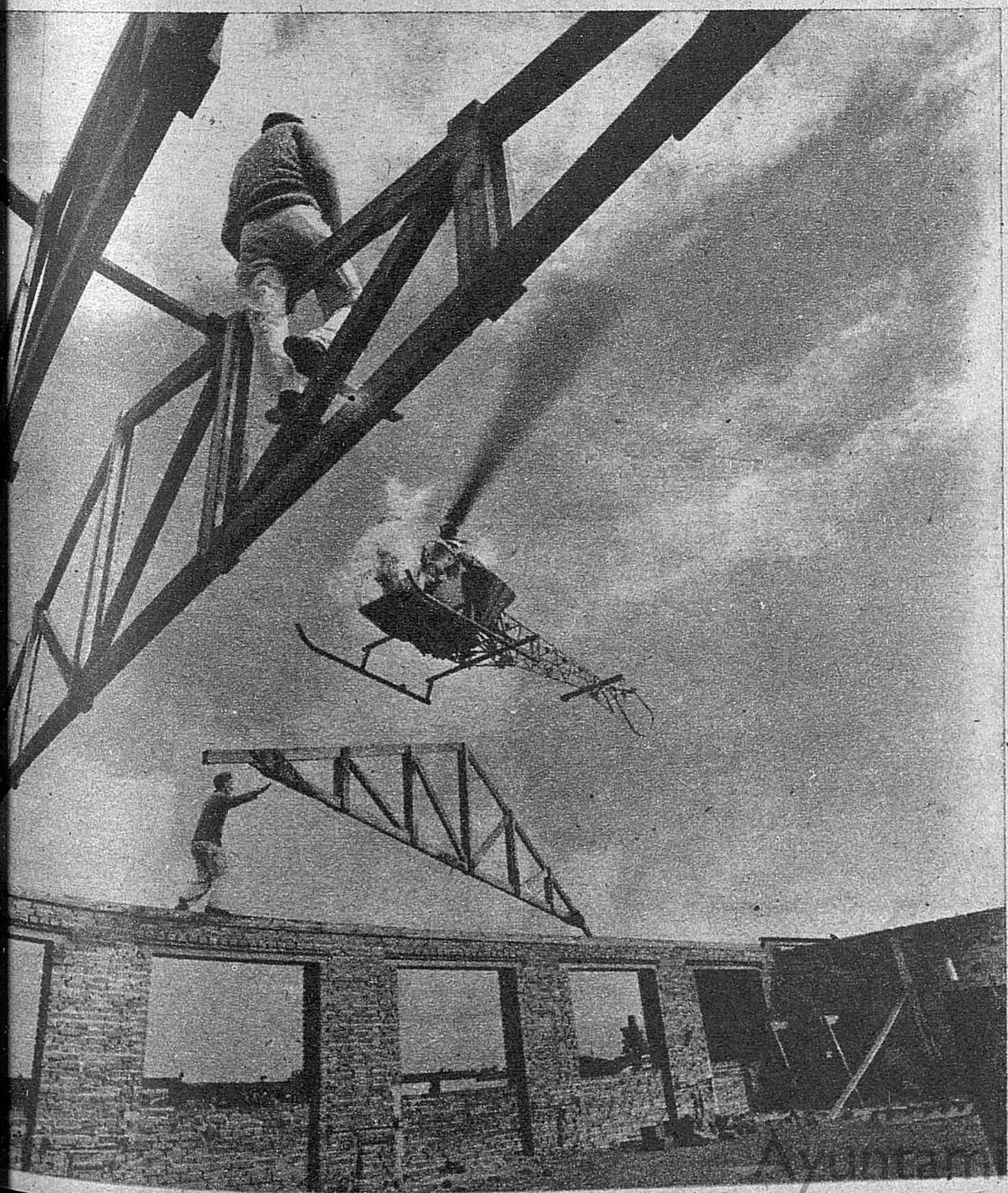
CUANDO EL TRABAJO TIENE ALAS.—En la construcción de una nueva factoría de Copenhague, un helicóptero colabora, como un productor más, en la mano de obra transportando vigas de doscientos kilos y realizando en catorce minutos lo que cinco obreros tardarían en hacer una hora. El helicóptero productor trabaja y vuela, y añade así a la eficacia de la tarea gracia y poesía. Habrá que cantar un día este símbolo de la máquina.—(Fotos Torremocha.)
