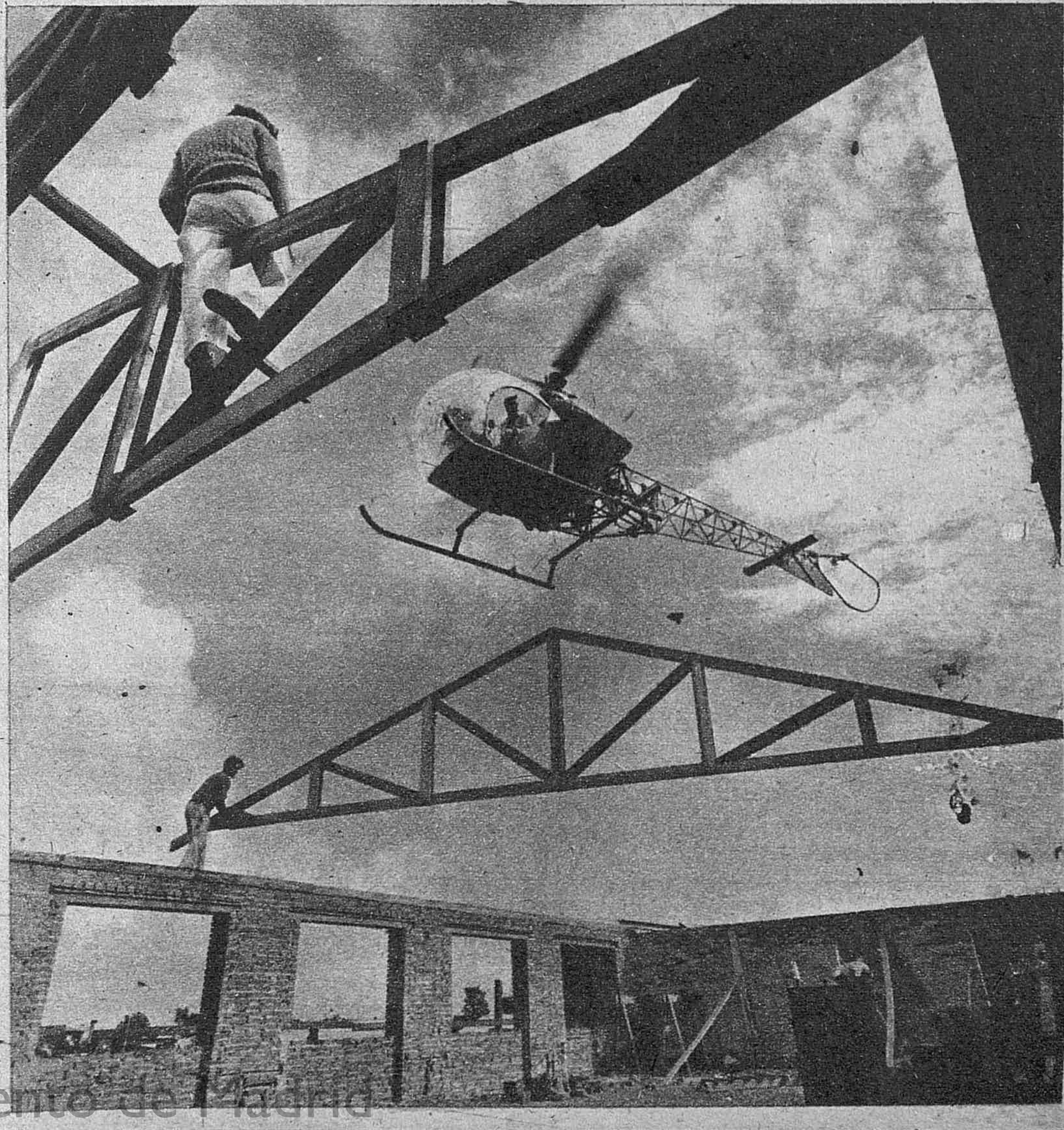
CUANDO EL TRABAJO TIENE ALAS.—En la construcción de una nueva factoría de Copenhague, un helicóptero colabora, como un productor más, en la mano de obra transportando vigas de doscientos kilos y realizando en catorce minutos lo que cinco obreros tardarían en hacer una hora. El helicóptero productor trabaja y vuela, y añade así a la eficacia de la tarea gracia y poesía. Habrá que cantar un día este símbolo de la máquina.—(Fotos Torremocha.)
