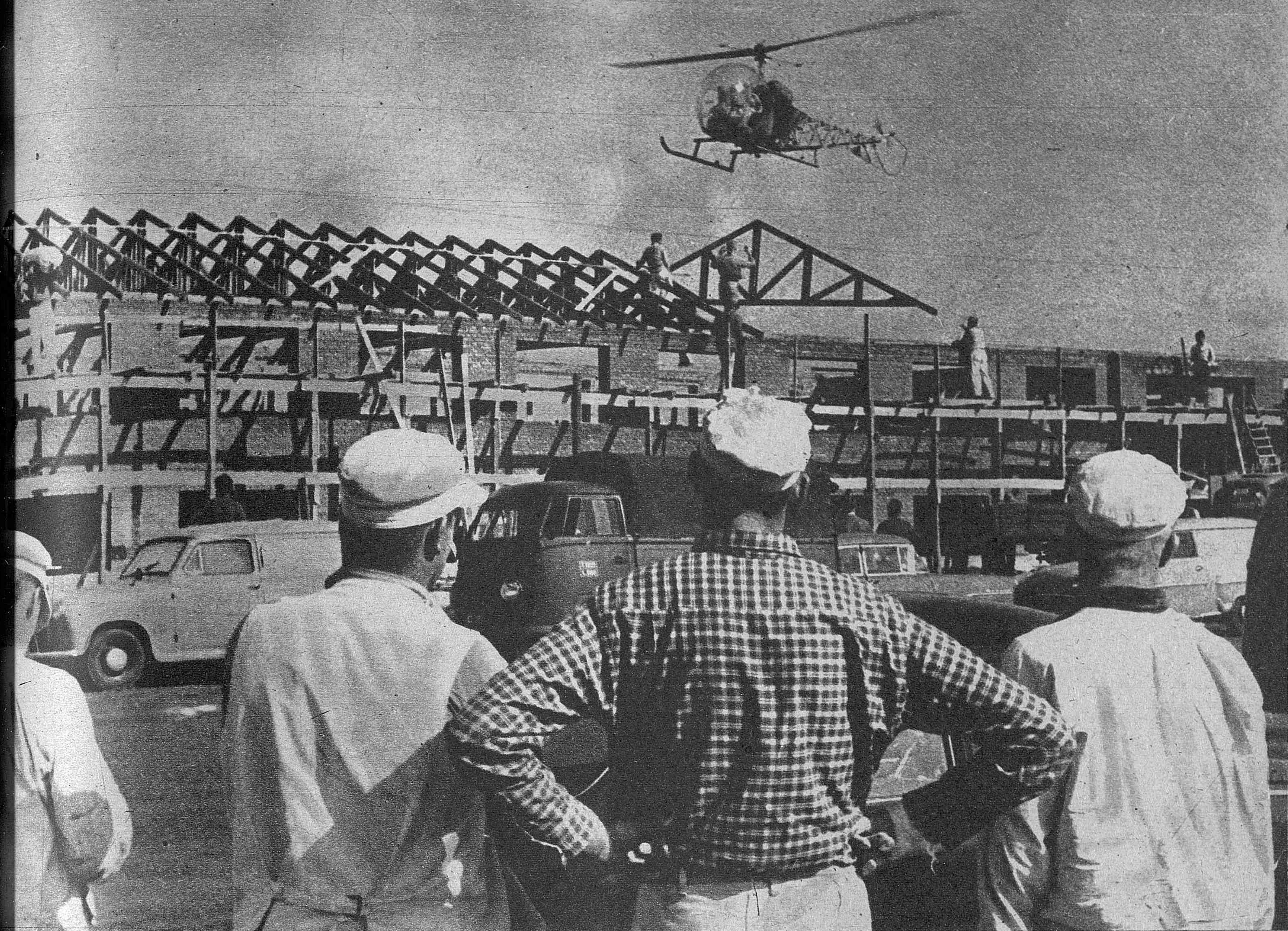
CUANDO EL TRABAJO TIENE ALAS.—En la construcción de una nueva factoría de Copenhague, un helicóptero colabora, como un productor más, en la mano de obra transportando vigas de doscientos kilos y realizando en catorce minutos lo que cinco obreros tardarían en hacer una hora. El helicóptero productor trabaja y vuela, y añade así a la eficacia de la tarea gracia y poesía. Habrá que cantar un día este símbolo de la máquina.—(Fotos Torremocha.)
