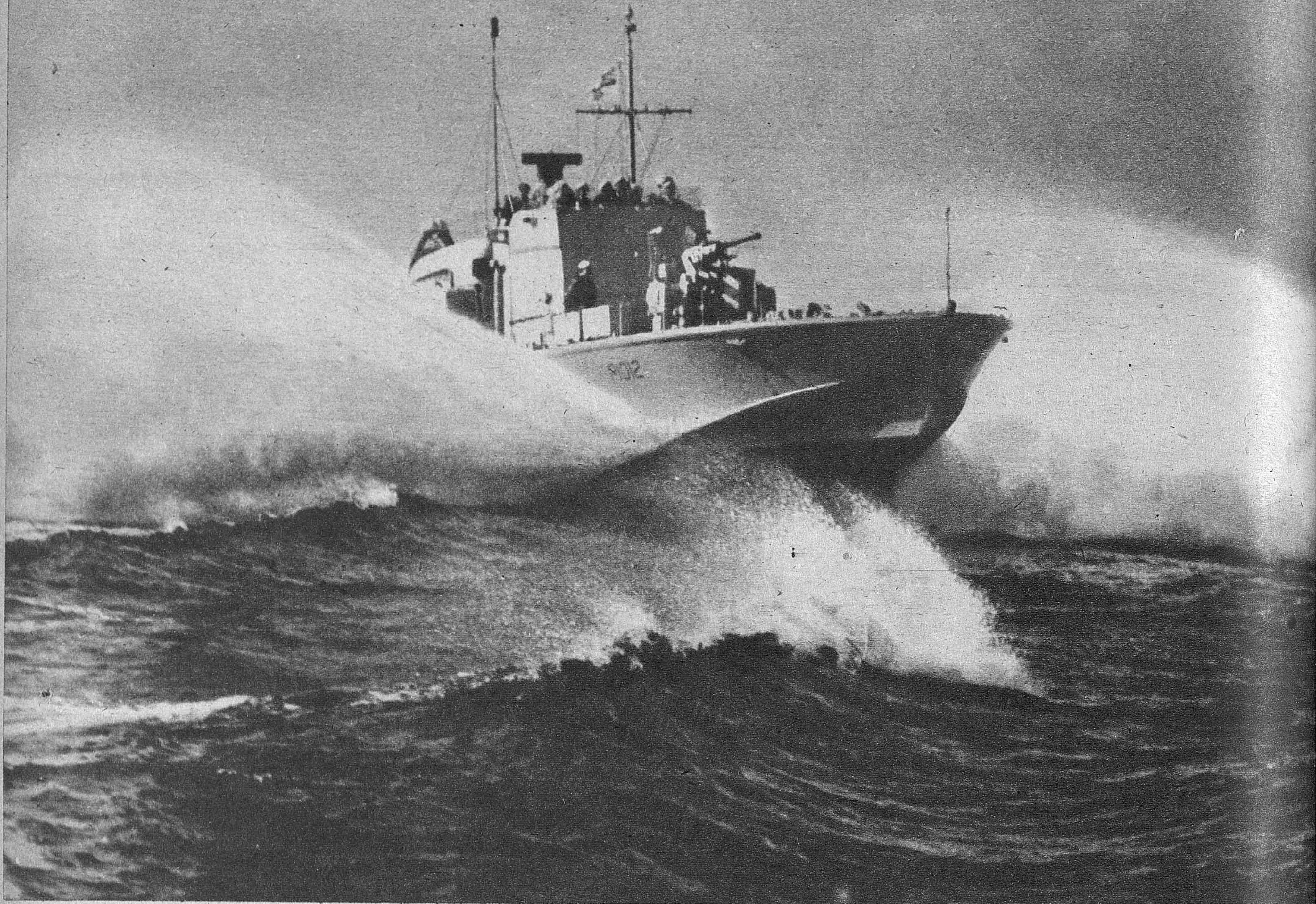
COMO UNA FLECHA SOBRE LAS OLAS. —A casi cien kilómetros a la hora navega esta lancha rápida alemana de cien toneladas de desplazamiento construida para la Marina alemana y considerada la nave de guerra más rápida del mundo. Puede ser armada con cuatro torpedos de veintiuna pulgadas y un cañón de cuarenta milímetros, y los técnicos la califican como arma ideal de defensa costera, que servirá para neutralizar los desembarcos.—(Cifra.)
