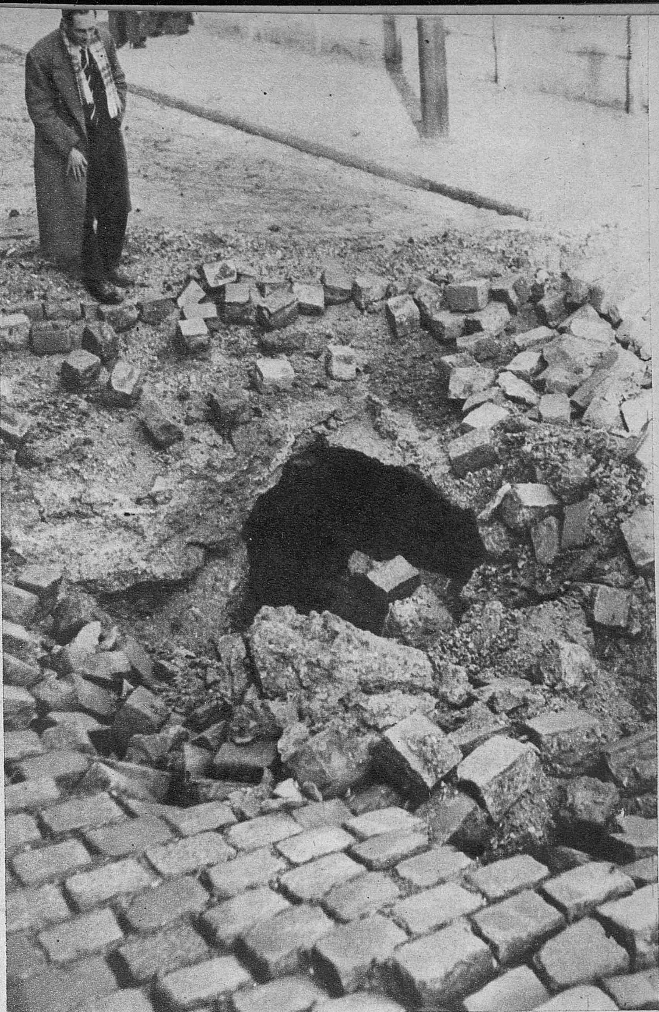
SOCAVONES EN PARIS. —Por lo que se ve, la exclusiva de los socavones no es madrileña; éste que ofrecemos aquí ocurrió en París, Puerta de Monreuil, y se produjo por rotura en una arteria de agua. — (Torremocha.)
