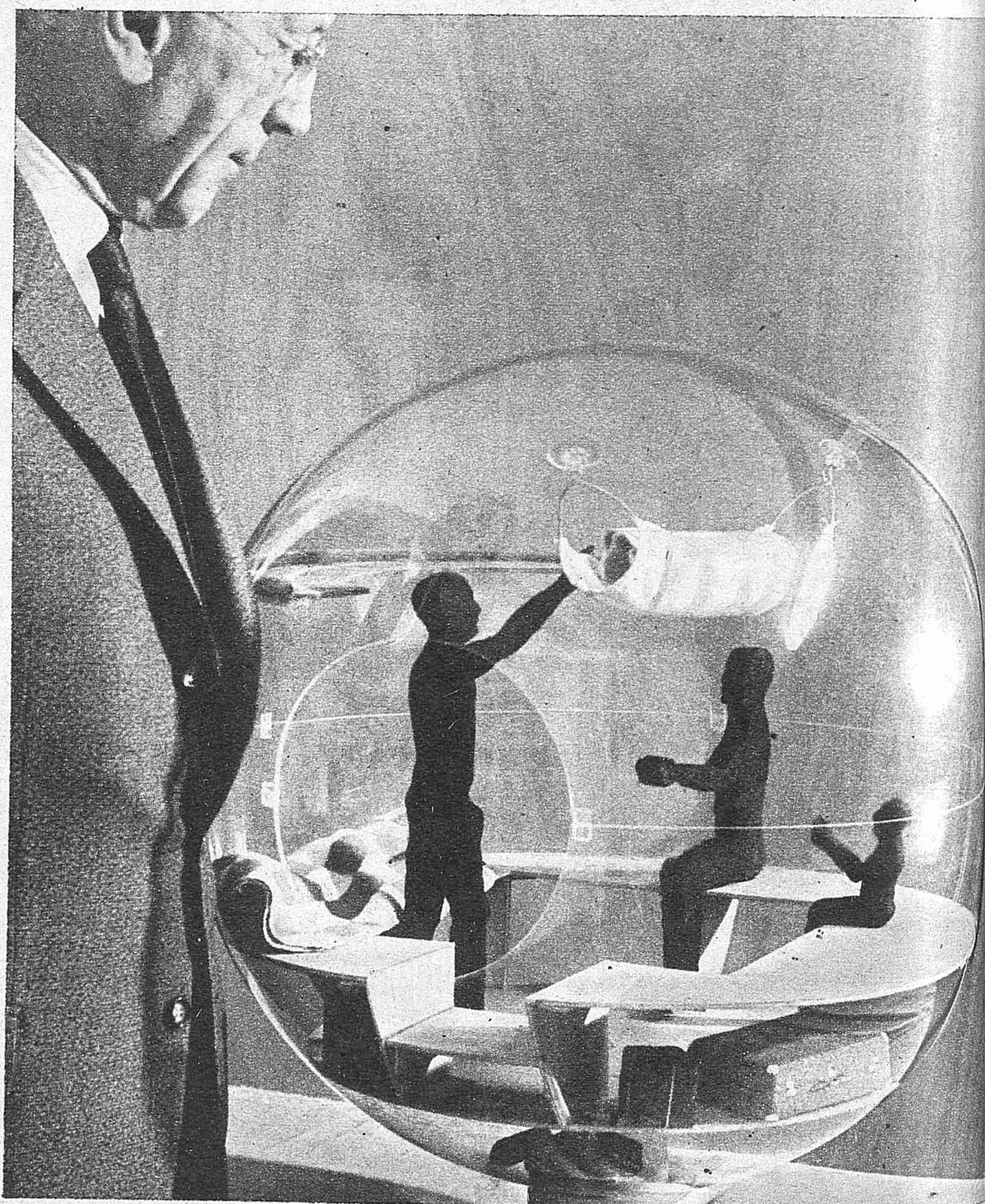
REFUGIO FAMILIAR. —En una Exposición organizada por la defensa aérea alemana se exhibe este modelo de refugio familiar. Está construido de acero y hormigón y protegido contra la radiactividad. Caben en él ocho personas
