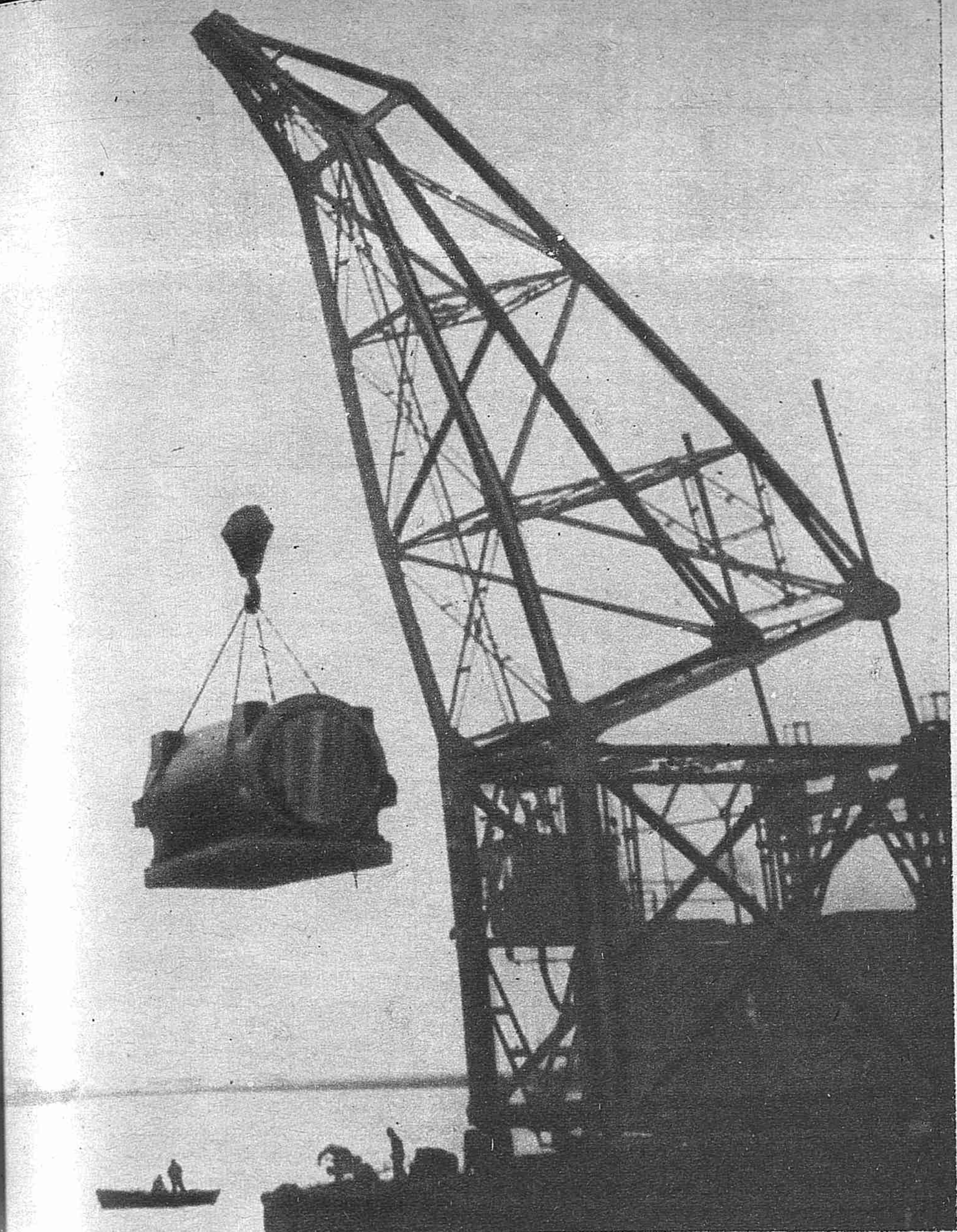
CENTRAL TERMICA EN HUELVA. —Ciento veintiséis toneladas pesa esta pieza que descarga la grúa y que desde Nueva York llega a Huelva. Es un estator generador destinado a la nueva central térmica «Cristóbal Colón»
