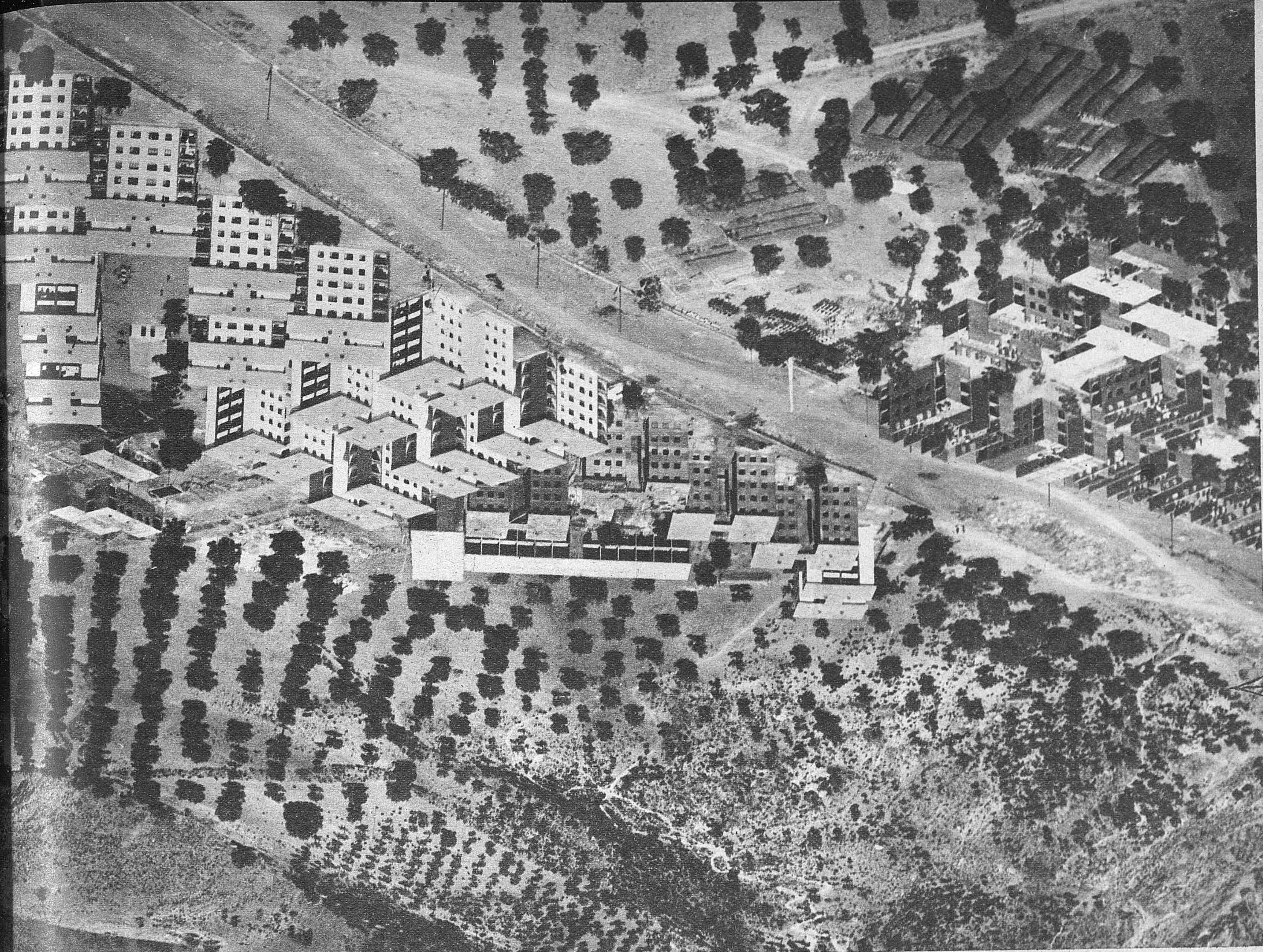
NUEVAS VIVIENDAS PARA LOS ANTIGUOS CHABOLISTAS DE MÁLAGA. —Vista aérea de las viviendas ya terminadas de la barriada «26 de Febrero» y de las que se hallan en construcción en «La Palmilla», en Málaga. Promovidas por la Jefatura Provincial del Movimiento, con subvención del Ministerio de la Vivienda y fondos de la Campaña de Caridad, ellas redimirán a la antigua población chabolista. En nuestras páginas interiores, más información
