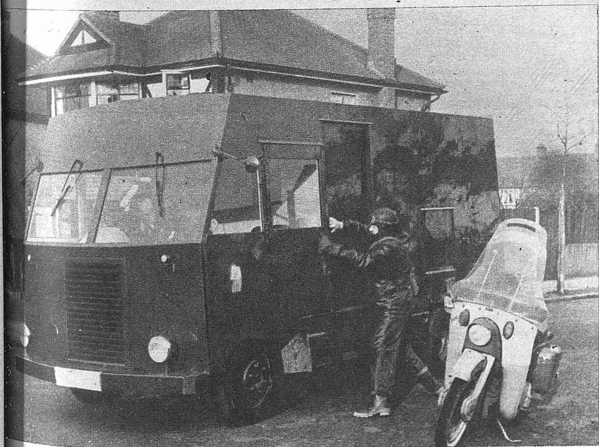
UNA CAJA DE CAUDALES CON RUEDAS. —Inmune a las balas y a los choques, esta furgoneta, especialmente preparada para frustrar cualquier ataque, constituye una verdadera y segura caja de caudales con ruedas.
