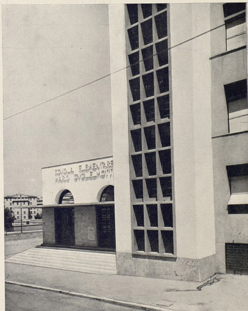
Detalle de la caja de escalera e ingreso principal. La estructura de las ventanas, de hormigón armado.
