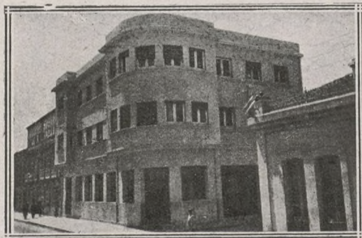
Magnífico edificio en el que están instalados los almacenes y oficinas
