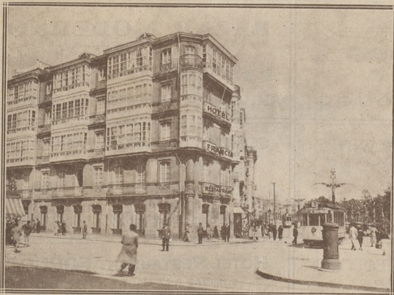
Hermoso edificio que ocupa el HOTEL ESPAÑA (antes Francia) instalado con todo confort: ascensor, calefacción central, baños y duchas y agua corriente en todas las habitaciones. Magnífico Restaurant con la mejor cocina de la Región. El edificio del HOTEL ESPAÑA está situado entre la alegre Alameda y la amplia calle de Juana de Vega, por lo que sus habitaciones amplias y llenas de luz son exteriores y disfrutan de magníficas vistas, la mayoría de ellas al mar.
