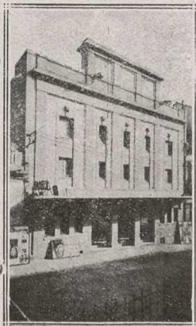
Hermoso edificio del Cine Capitol
