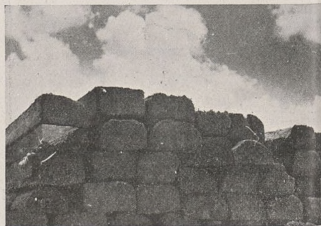
Las traviesas esperan que esté hecha la explanación para ser tendidas.
