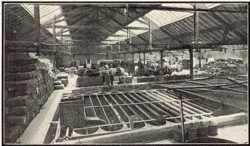
SALÓN DE PILAS PARA LA PREPARACIÓN DE LAS PASTAS
