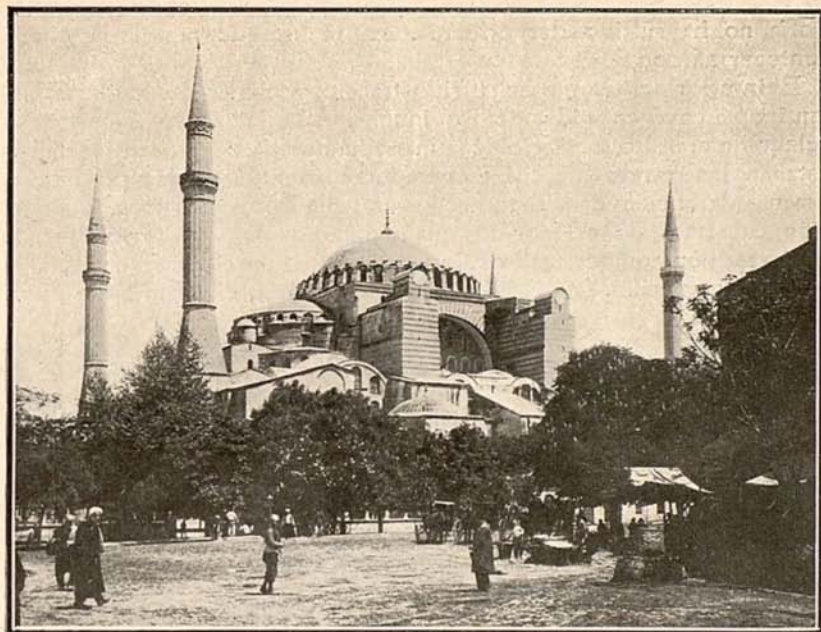
VISTA EXTERIOR DE SANTA SOFÍA EN CONSTANTINOPLA
