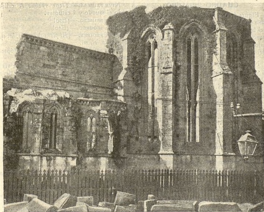
RUINAS DE LA IGLESIA DE SANTO DOMINGO
