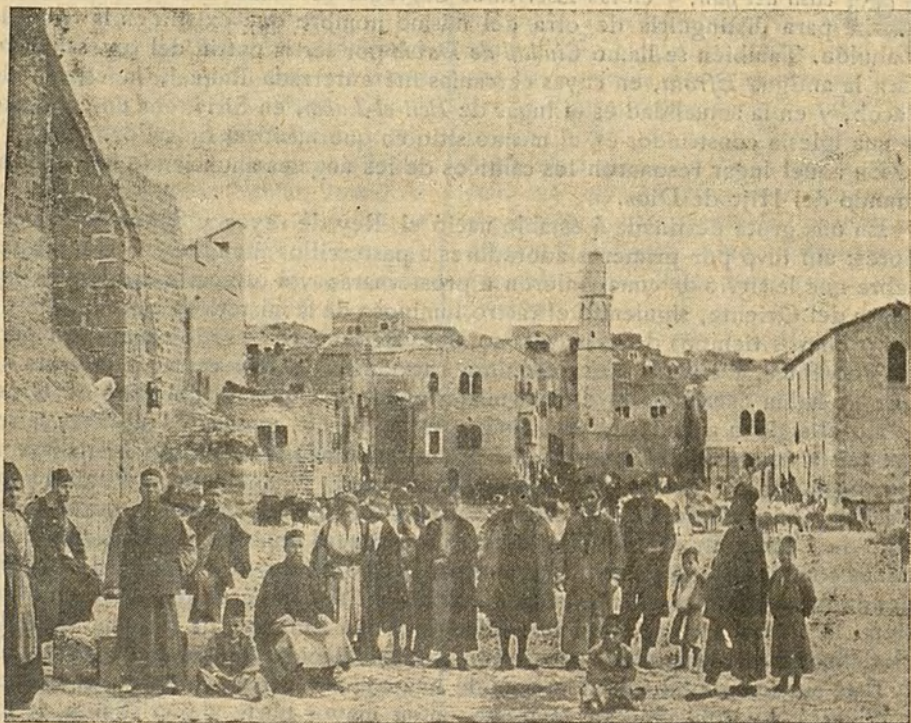
VISTA DE BETLEHEM
