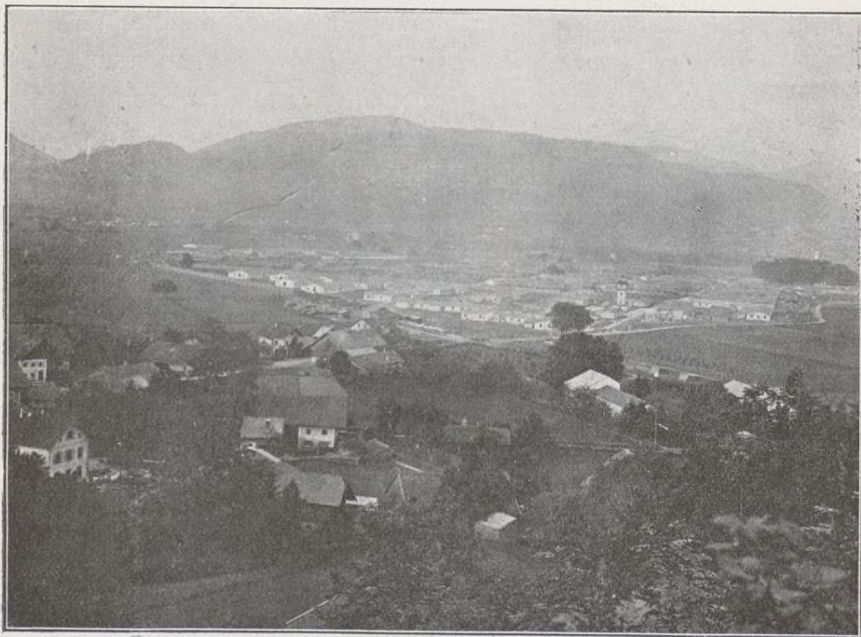
CAMPAMENTO DE GROEDIG.—VISTA GENERAL
