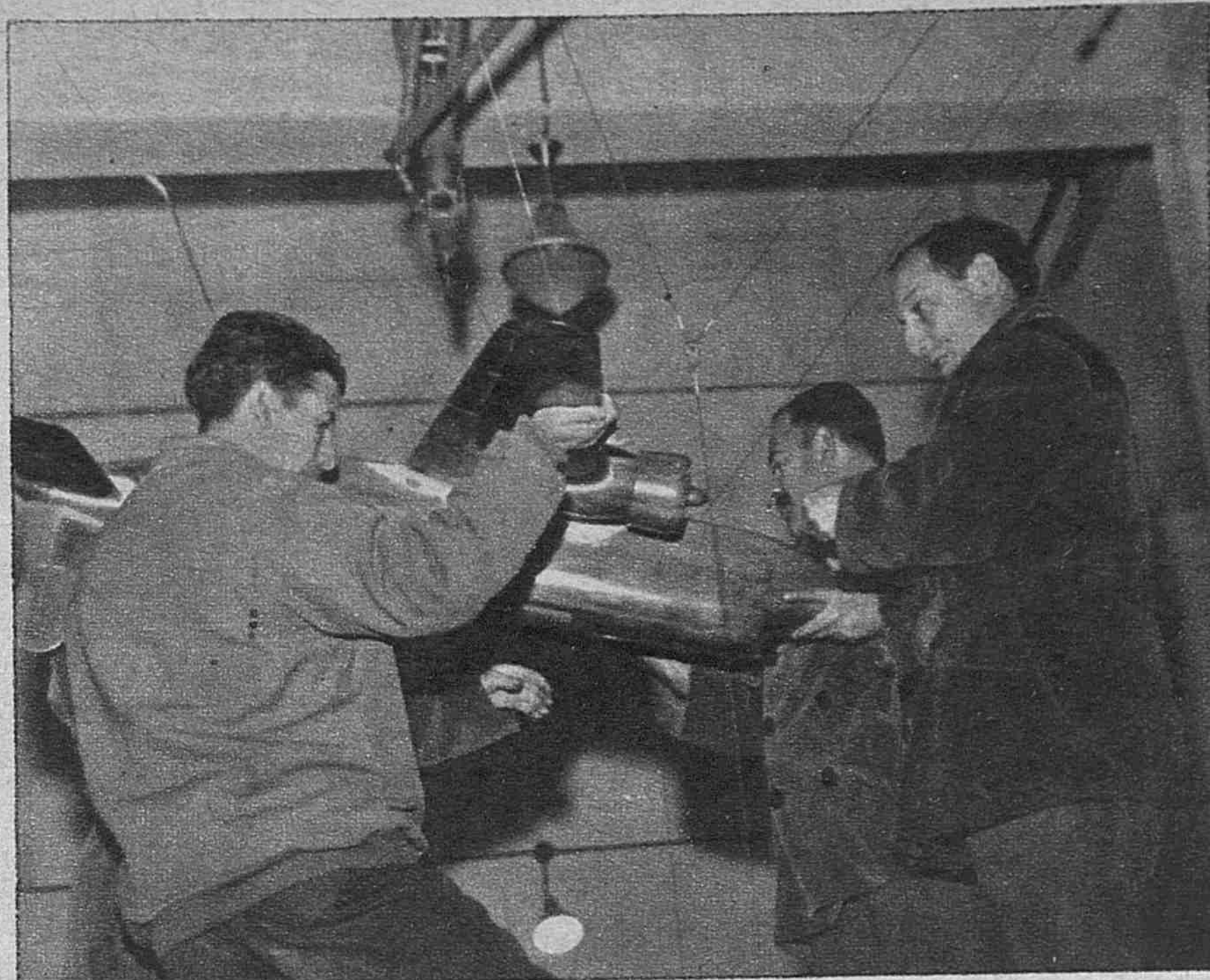
Preparación de la maqueta de un avión en un túnel.
