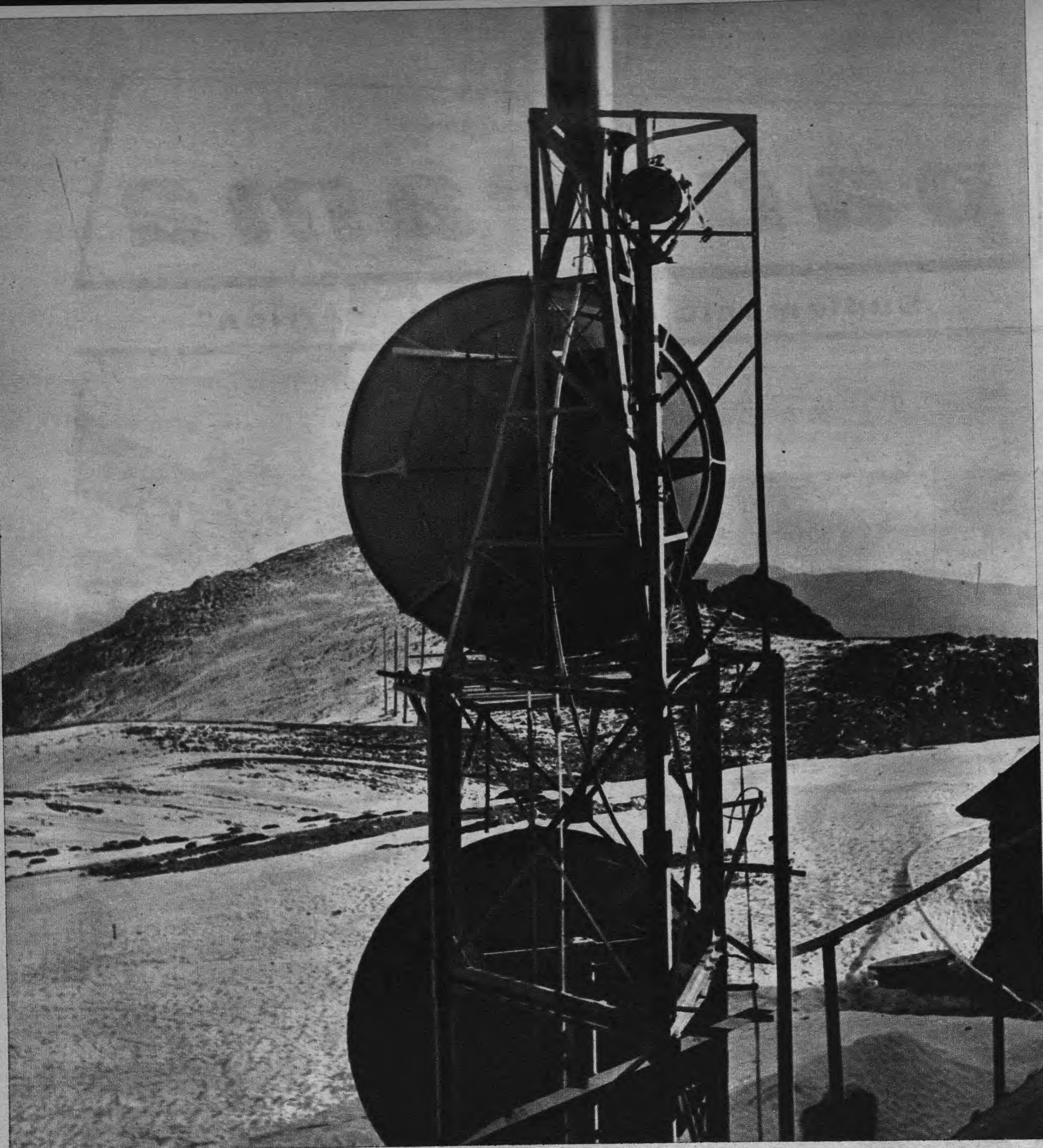
Parábolas receptoras de microondas por las que se reciben las señales de imagen y sonido enviadas desde los estudios de Madrid
