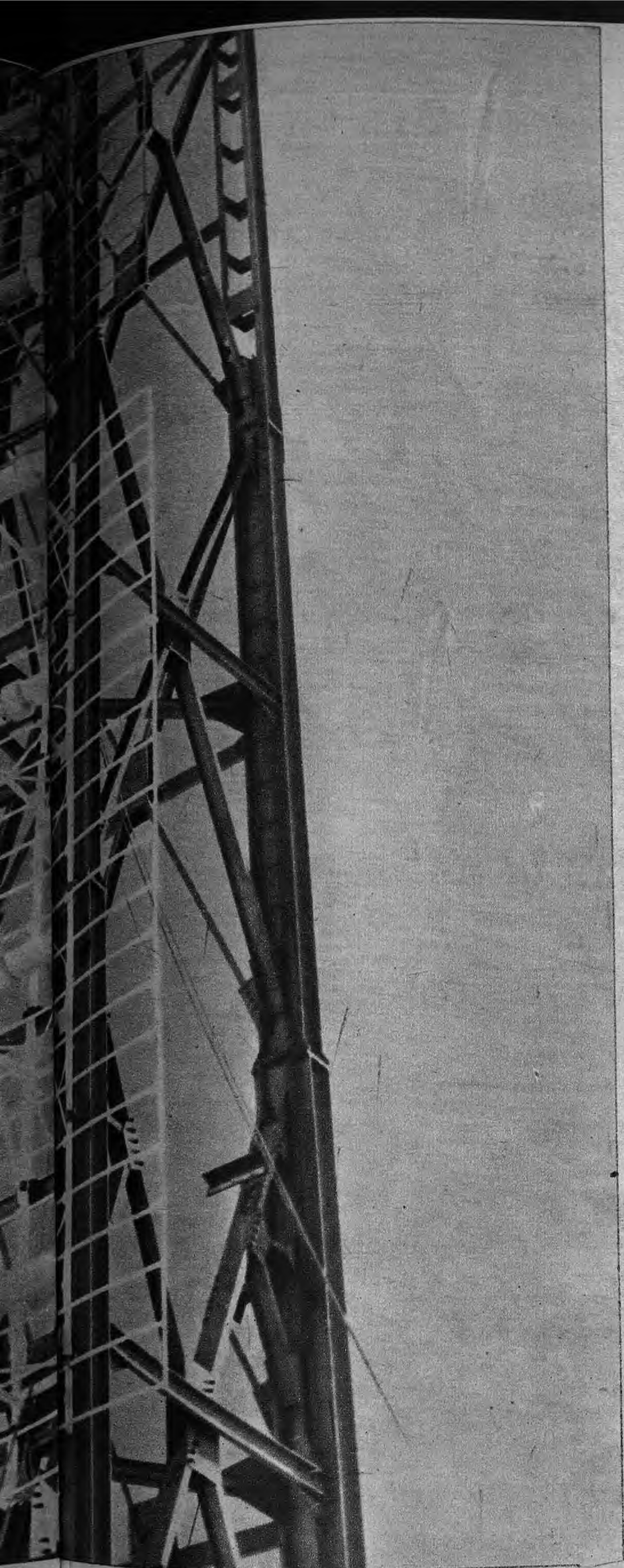
Instalación de las cortinas de dipolos en la antena de Navacerrada
