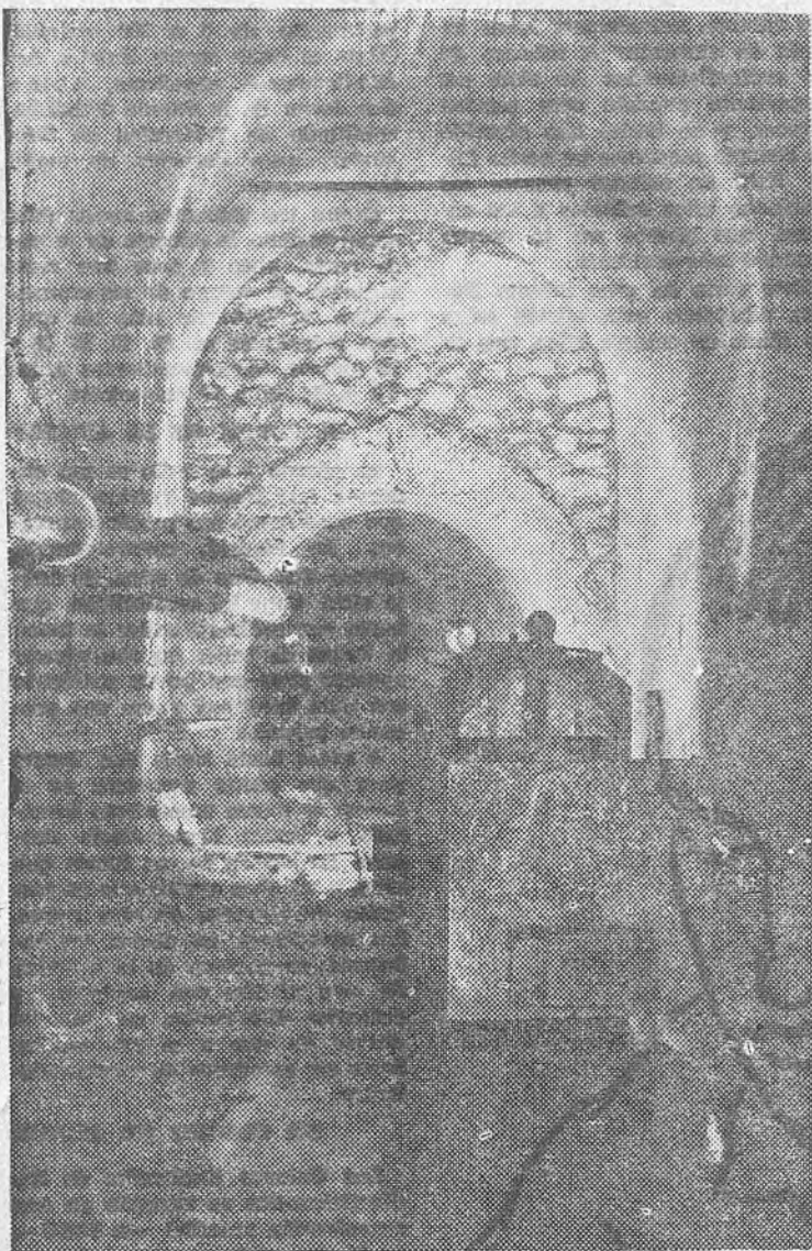
Sección primitiva del túnel del Sabinal, que fue preciso modificar por causa de los fuertes empujes del terreno
